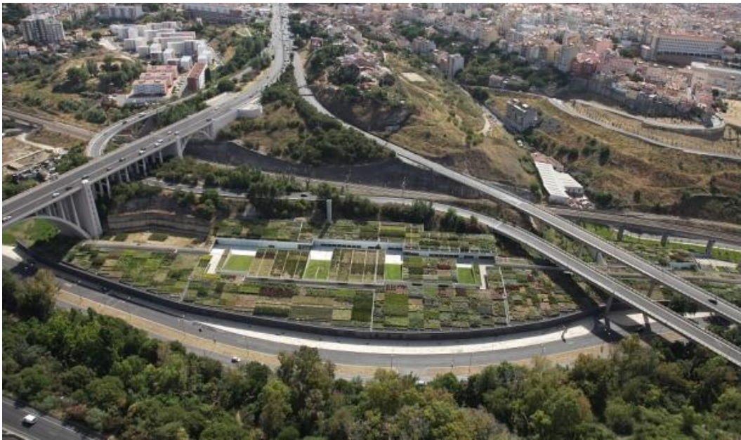
Figura 9.4 – Vista área da ETAR de Alcântara [39].
