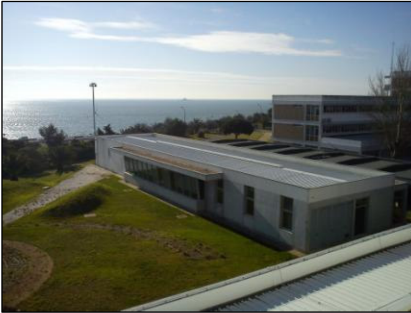
Figura 3 – Fotografia do Centro de Controlo de Tráfego Marítimo em Paço de Arcos
