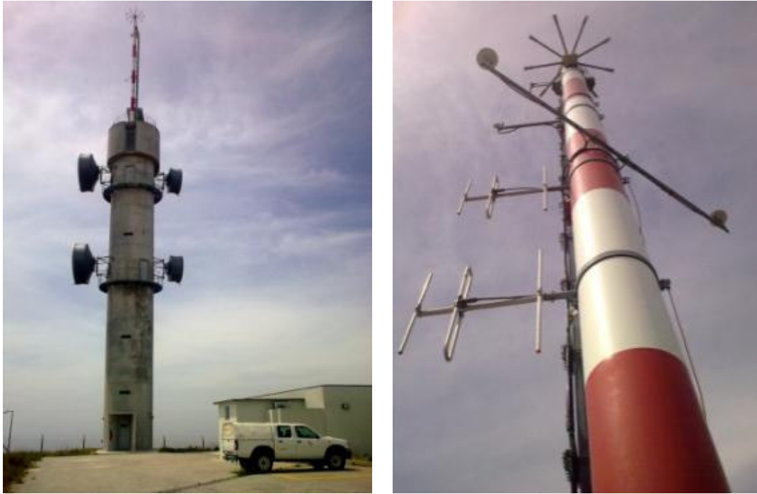
Figura 19 – Fotografias da Torre de Freitas e do respetivo mastro
