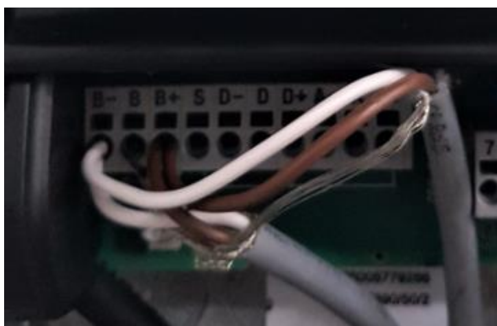
Figura 34 – Ligação Modbus no caudalímetro
