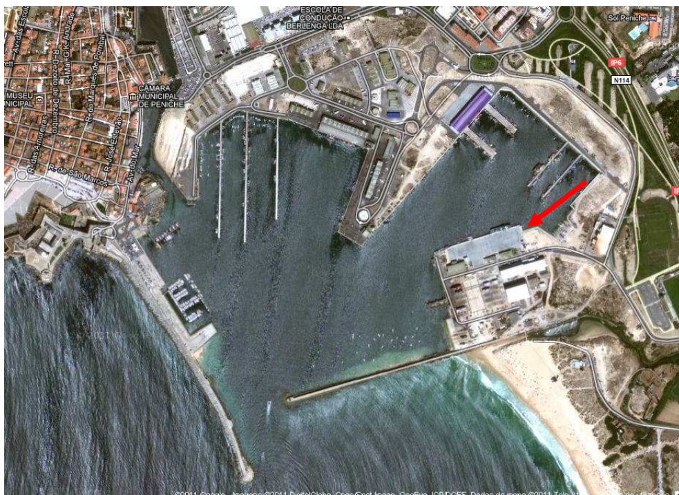
Figura 1- No interior do porto de Peniche
