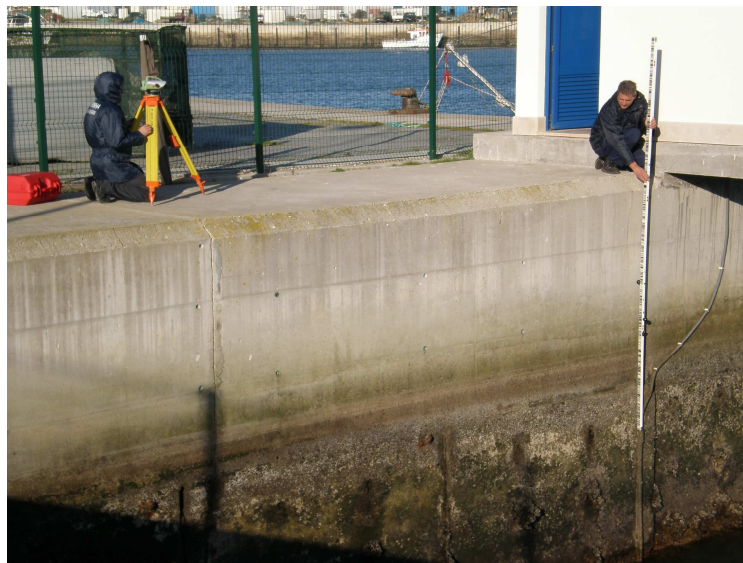
Figura 8- Nivelamento de sensor de pressão
