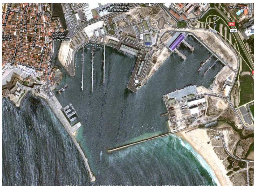
Figura 1 - No interior do porto de Peniche
