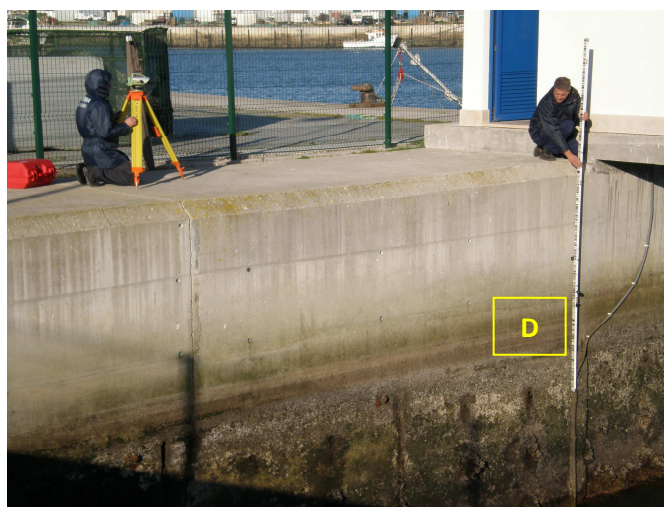
Figura 8 – Trabalhos de Nivelamento
