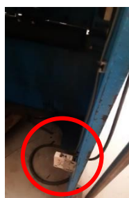
Figura 3 – Sensor de bloqueio, localizado na zona traseira de uma guilhotina (Fonte: Escola Profissional de Setúbal)
