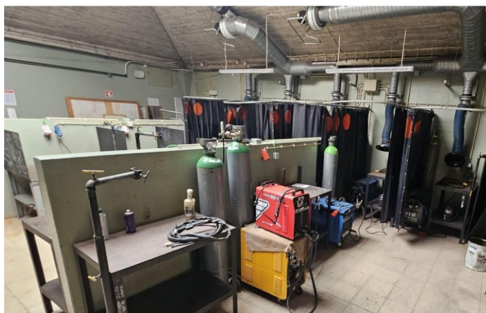
Figura 15 - Área de Soldadura Arco Elétrico (MIG/MAG e TIG)
