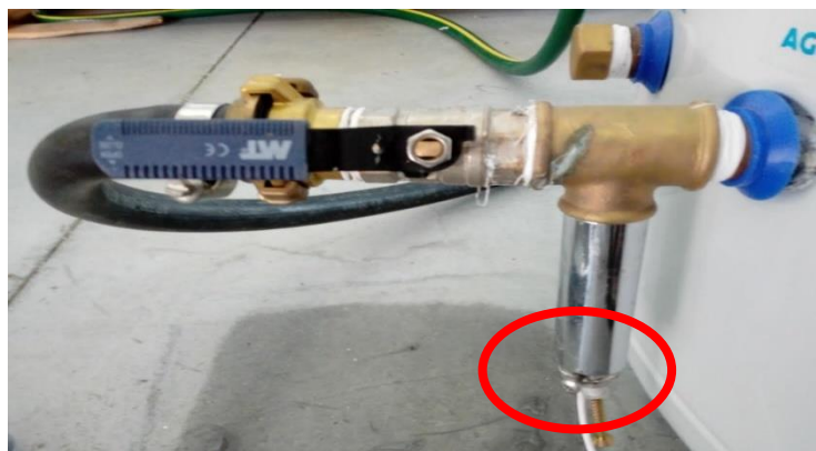
Figura 21 - Localização do sensor de temperatura da água da entrada
