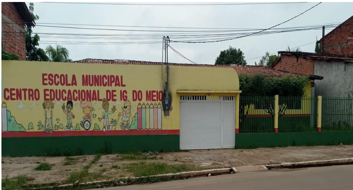
Foto 1 – Fachada da escola
