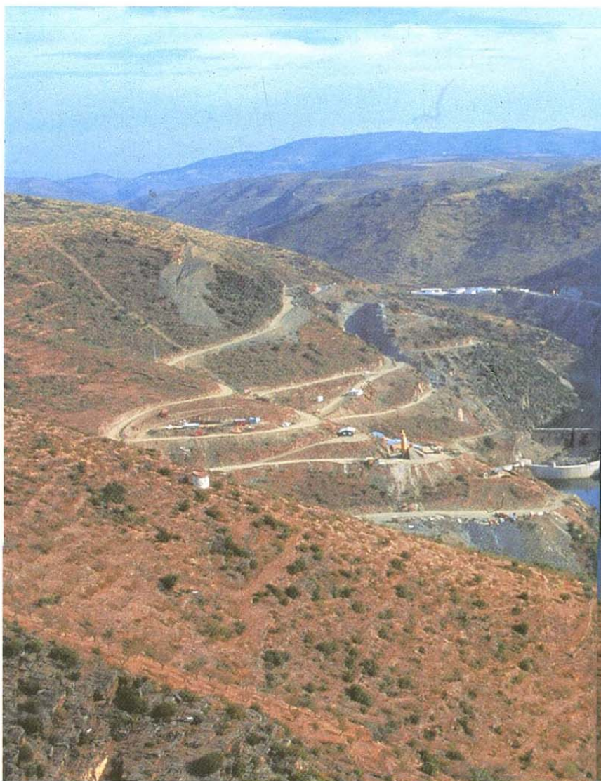
Vista de montante para jusante sobre as obras da barragem que estava em construção em Foz Côa.
