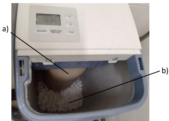
Figura 38. Descalcificador e seus componentes. a) Resina. b) Sal.
