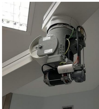
Figura 60. Motor para auxílio de movimento vertical do pendente sobre a junta de rotação.
