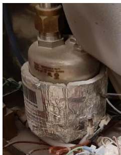
Figura 35. Caldeira de esterilizador.
