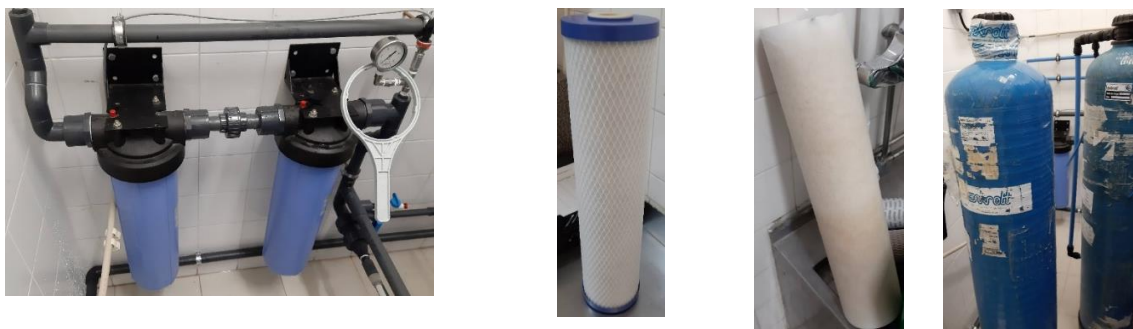
a) b) c) d) Figura 39. Filtros de sedimentos e de carvão ativo. a) Visão exterior dos filtros. b) Filtro de carvão ativo. c) Filtro de partículas. d) Botija que auxilia na remoção de cloro.
