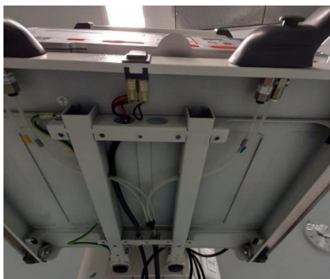
Figura 59. Parte inferior do pendente aberta. Destacando um dos punhos e botão para libertação do pendente, onde se veem as válvulas e tubos de ar correspondentes.
