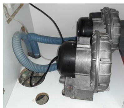
Figura 55. Motores de sucção das cadeiras dentárias.
