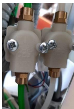
Figura 54. Relés de controlo do sistema de enchimento do copo e torneira da cadeira dentária.
