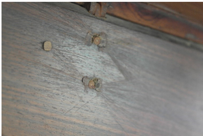
Figura 83 – Parafusos de fixação das dobradiças aos painéis laterais e marcas de ferramenta.
