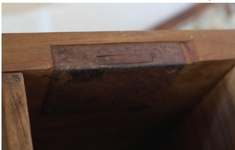
Figura 213 – Alteração das caixas de fechaduras.
