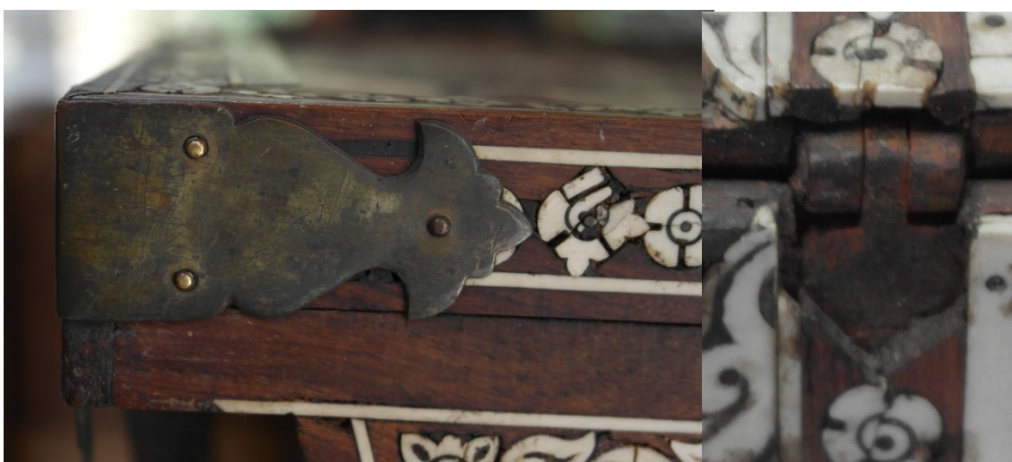
Figura 211 – Alteração dos elementos metálicos de cobre.
