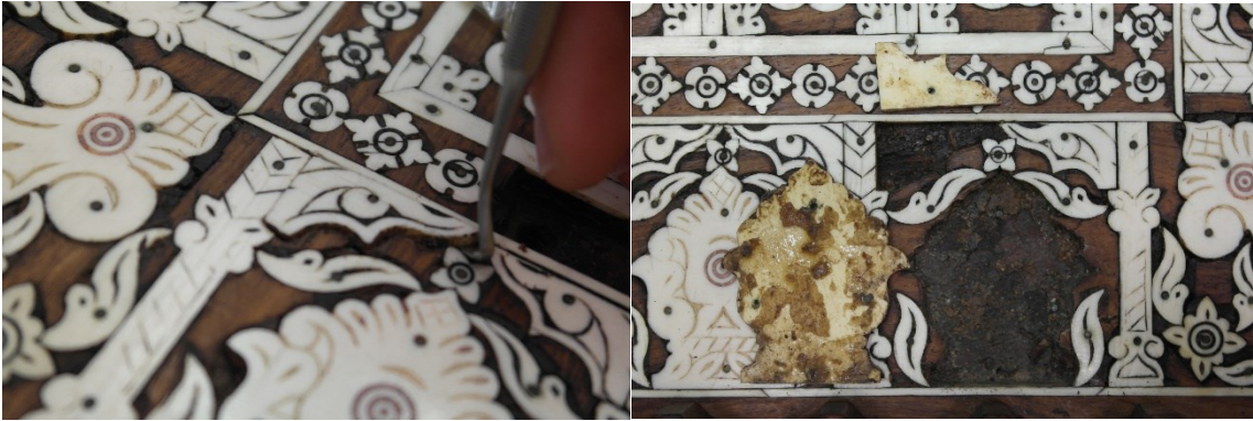
Figura 244 – Levantamento de embutidos em risco de destacamento ou fratura.
