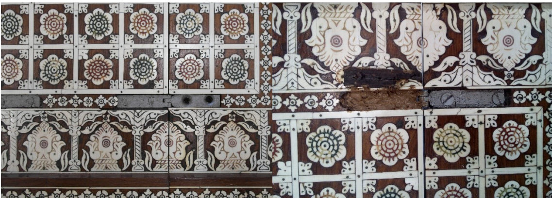
Figura 297 – Montagem das dobradiças.
