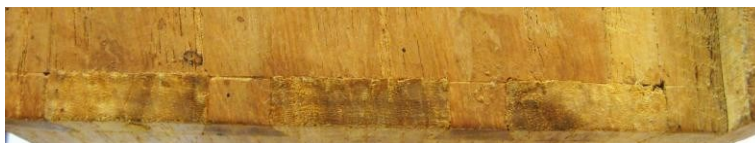
Fig. 12 – Observação de três partes do elemento (4) em secção transversal.
