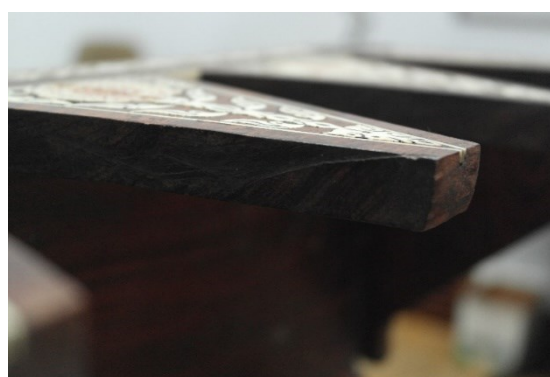
Figura 65 – Sulcos na madeira dos montantes, semelhante às marcas de graminho.
