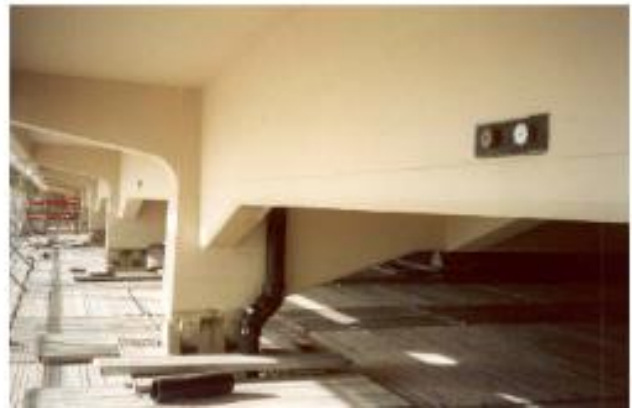
Fig. 101 – Reforço de vigas e controlo de qualidade (Costa et al. , 2004).
