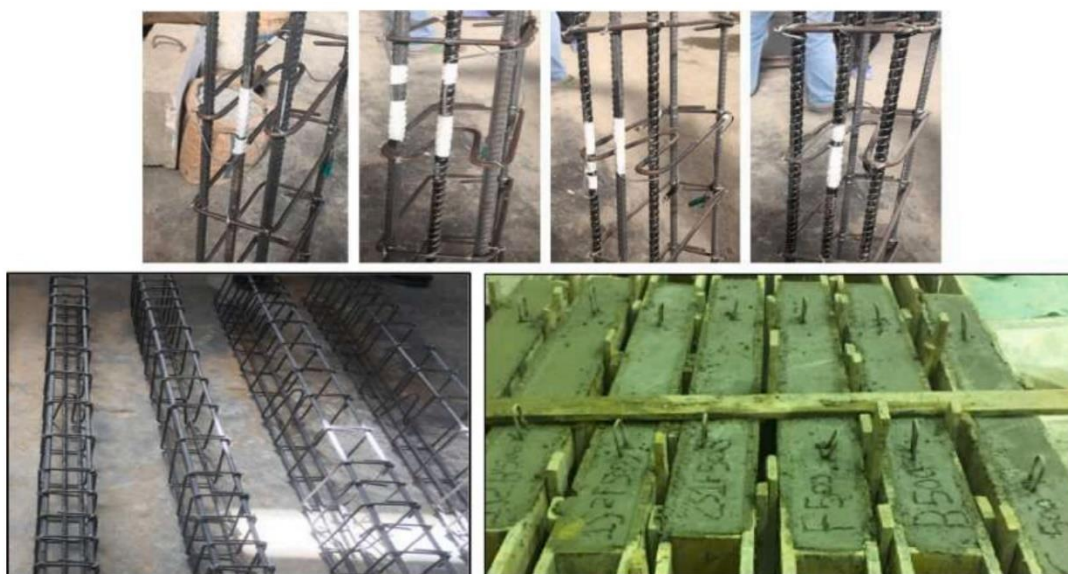
Fig. 82 – Detalhes das armaduras, e cofragem da viga (Hassan et al. , 2021).
