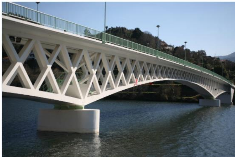
Fig. 102 – Ponte de Mosteirô sobre o Rio Douro - Reforço Estrutural (Teixeira Duarte, 2021).
