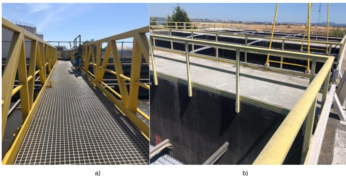
Fig. 122 – Estrutura em perfis GFRP, a) passadiço, b) guardas, ETAR Barreiro (Autor, 2021).
