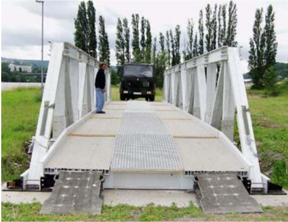
Fig. 54 – Ponte protótipo da RWTH-Aachen, Alemanha, 2002 (Teixeira, 2007).
