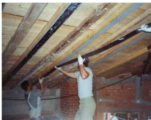
Fig. 48 – Exemplo de aplicação de FRP numa estrutura de madeira (SIKA, 2021).
