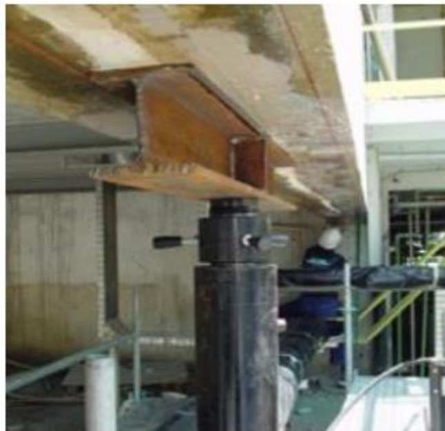
Fig. 111 – Alívio da sobrecarga por auxílio de macaco hidráulico (Monteiro, 2017).
