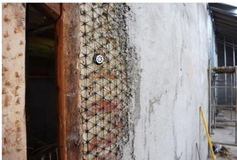
Fig. 51 – Aplicação de uma rede de polimérico revestimento de base cimentícia (Menezes, 2017).
