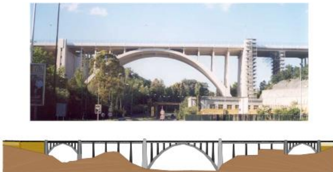
Fig. 98 – Vista Geral e alçado do Viaduto Duarte Pacheco (Costa et al. , 2004).
