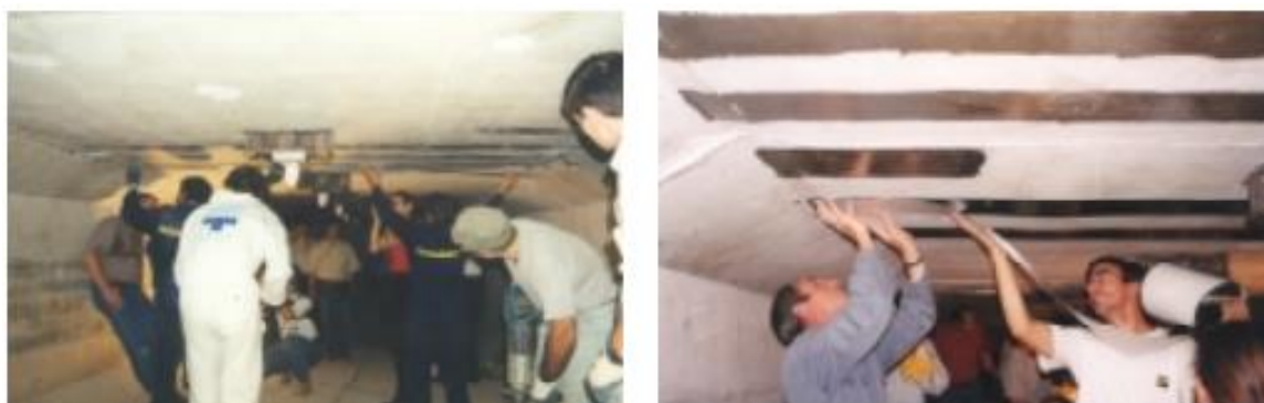
Fig. 97 – Aspeto de colocação do sistema curado in situ (mantas) (Juvandes, 1999) .
