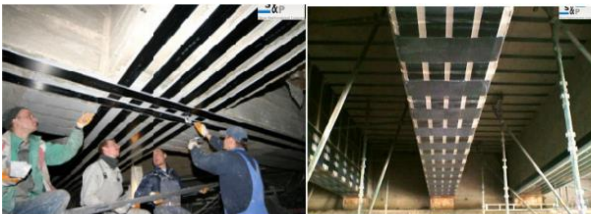
Fig. 43 – Exemplo de aplicação do método EBR (Sena, 2002)
