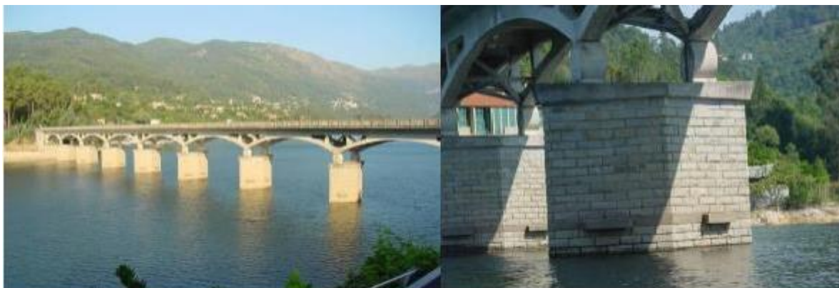
Fig. 108 – Ponte sobre o Rio Caldo, Gerês (Monteiro, 2017).
