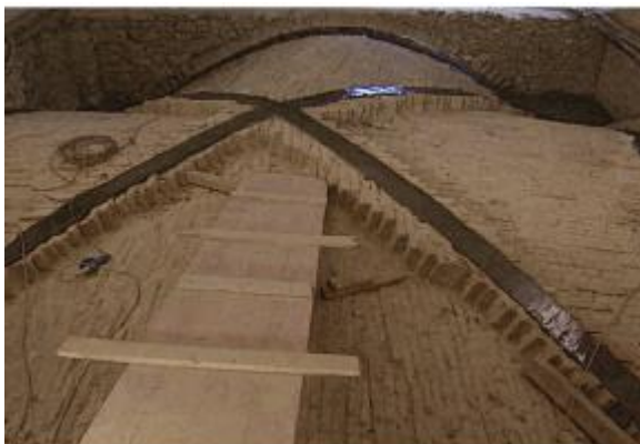
Fig. 50 – Reforço de abóbodas com tecido CFRP (Rodrigues, 2005).
