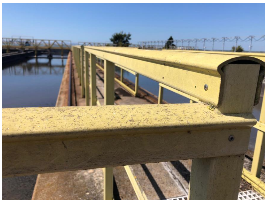
Fig. 127 – Fibras expostas ETAR Barreiro (Autor, 2021).
