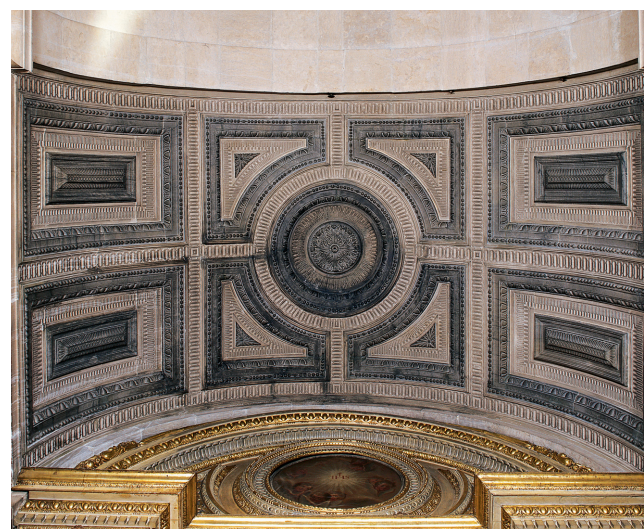
Intradorso do arco da Capela de S. Francisco Xavier, Igreja de São Roque, Lisboa
