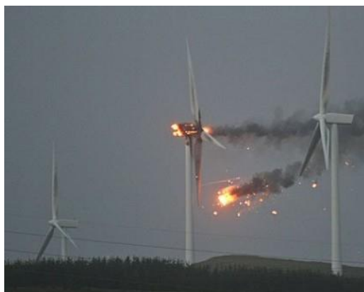
Figura 4.17: Incêndio num aerogerador provocado por avaria do seu gerador [61].
