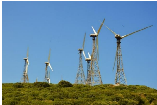
Figura 3.43: Aerogeradores com torre de treliça [46].
