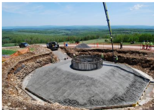
Figura 3.44: Fundação para uma turbina eólica onshore [48].
