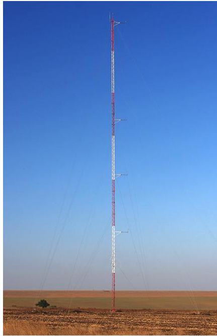
Figura 2.4: Torre meteorológica para avaliação de recurso eólico [11].
