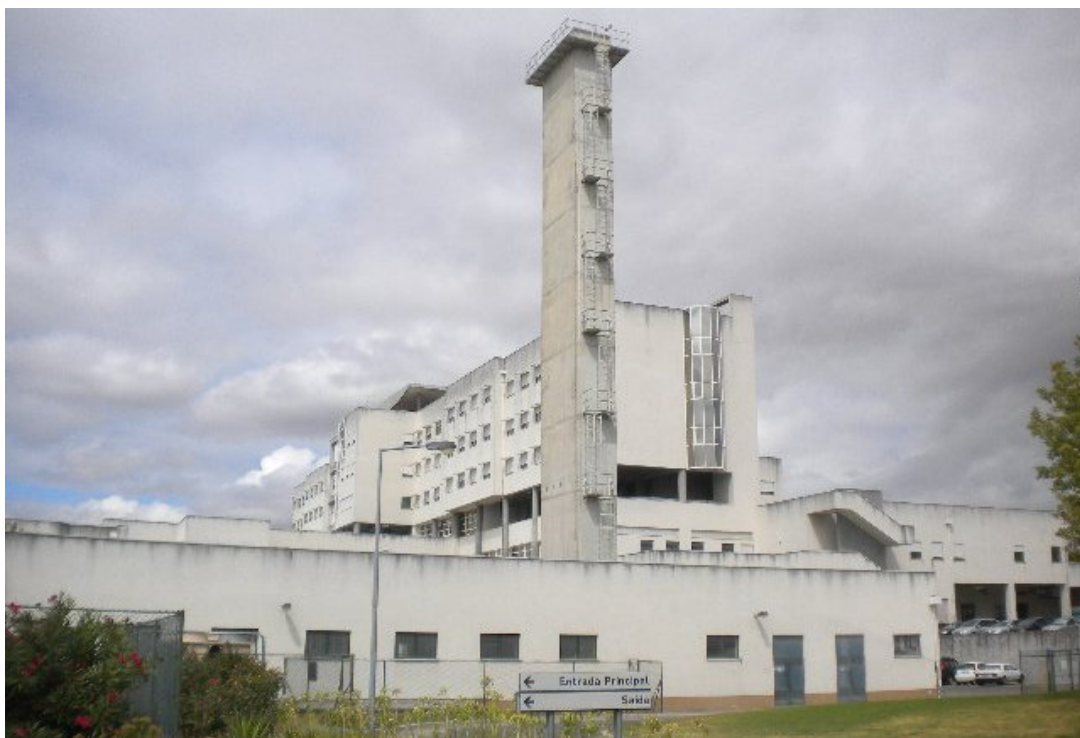
Figura 8 – Vista exterior da Central Térmica
