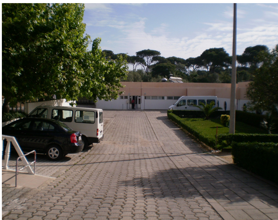
Figura 2 - Edifício Principal do Jardim de Infância «O Pica-pau»
