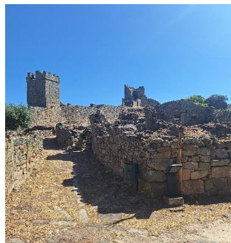
Figura 82. Torre do Castelo de Marialva. Fonte: do autor
