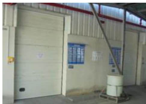
Figura 21 - Armazém dos químicos
