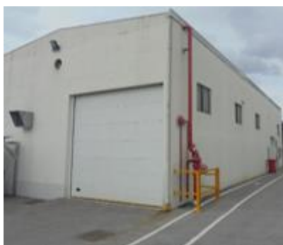
Figura 20 - Oficina da manutenção geral
