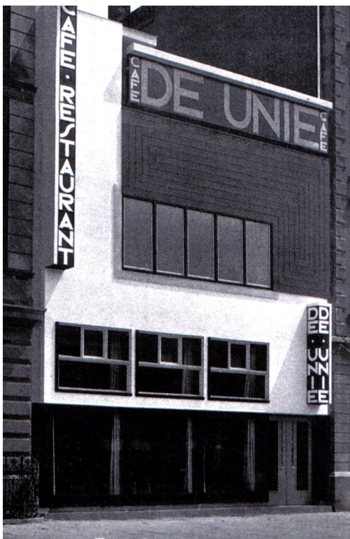
82 “O Café-Restaurant De Unie, em Amsterdão, foto histórica. O edifício já não existe.”
