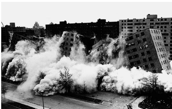
Imagem 3: Demolição do Bairro Pruitt-Igoe
