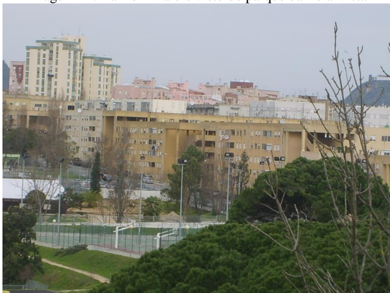
Imagem 12: Edifício do Bairro Amarelo degradado
