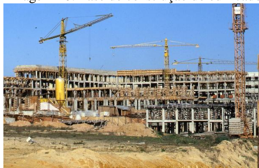
Imagem 10: Fase de construção do edifício
