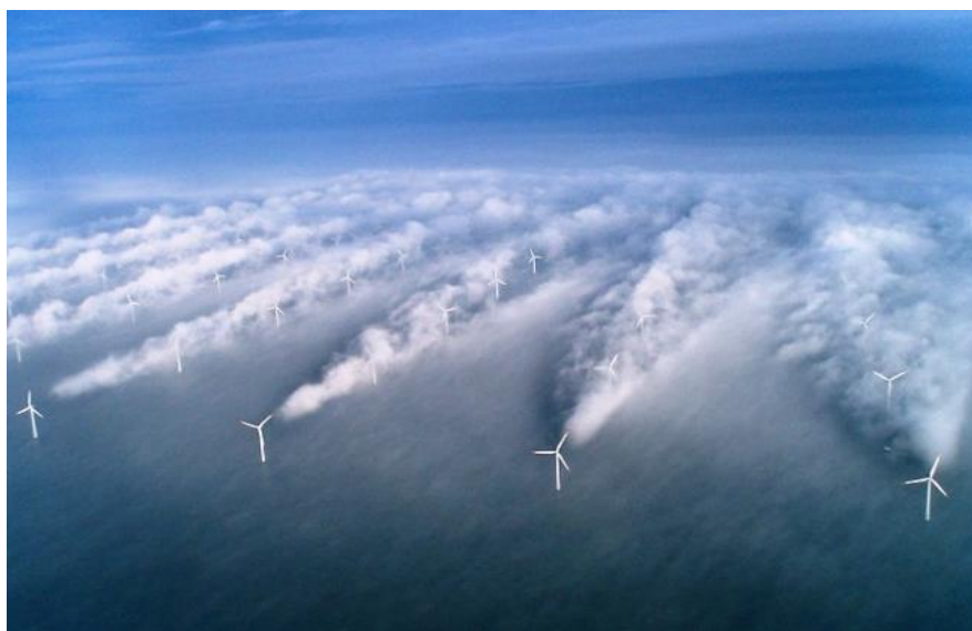
Figura 24- Efeito de esteira no mar do Norte ( The Civil Engineer , 2020)
