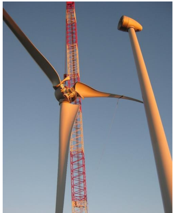
Figura 45- Subida do conjunto Hub e pás
