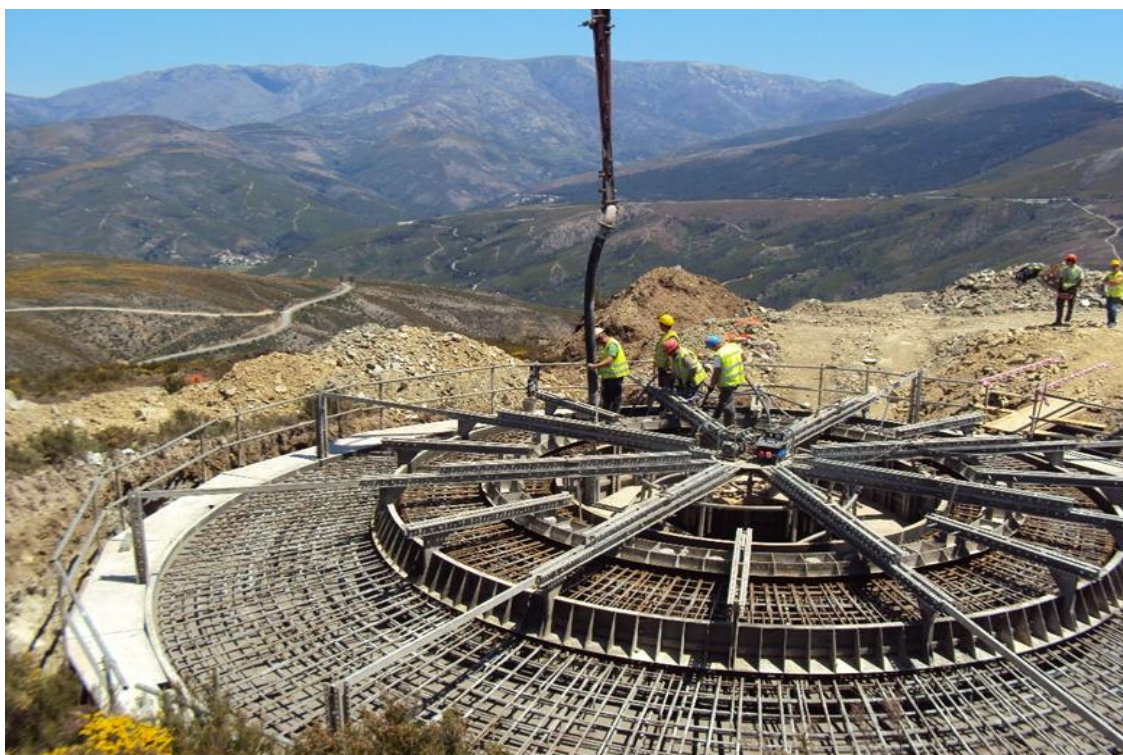
Figura 29- Betonagem de Fundação de um aerogerador
