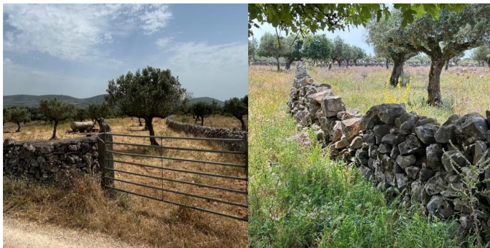
Figura 14 - Muros de pedra na SSA (imagem de autoria própria).
