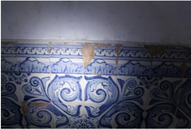
Figura 155 - Devido a sais e humidade, o vidrado de alguns azulejos já começaram a destacar.
