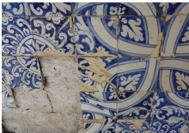
Figura 197 - Fraturas todas do mesmo sentido, indiciam o movimento de águas no material.
