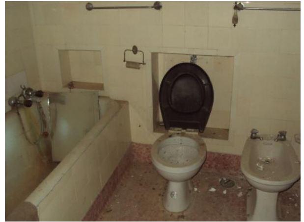
Figura 176 - Embora os azulejos apresentem bom estado de conservação, ainda não estão afetados pelo meio.
