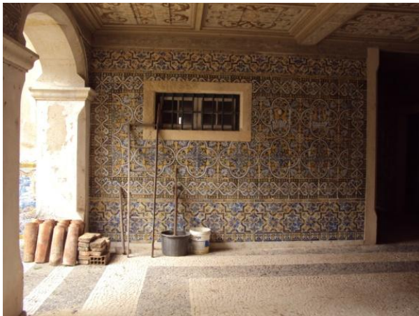
Figura 16 - Galeria do pátio pequeno.
