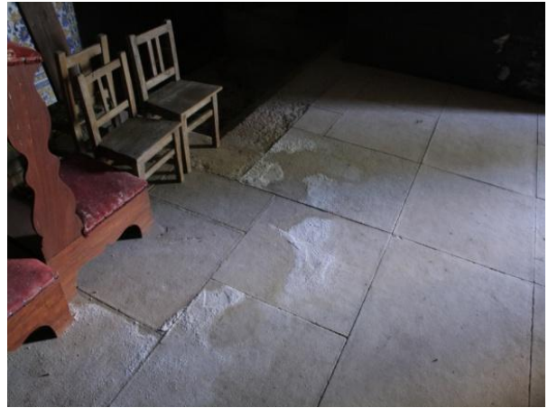
Figura 125 - Encontram-se alguns sais a sair pelas juntas e pelas fissuras no vitrado.
