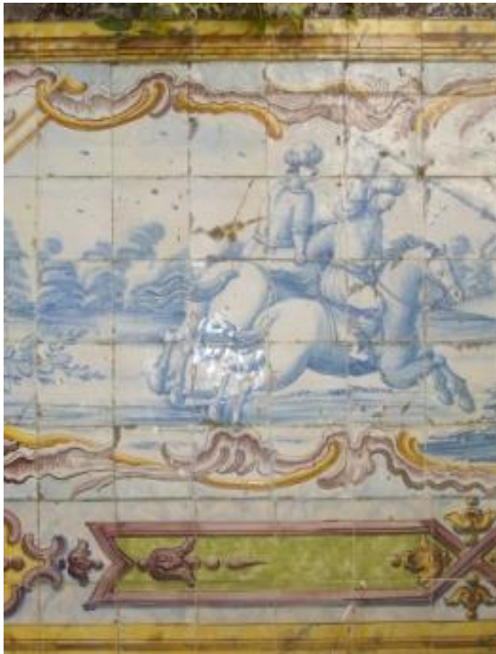
Figura 199 - Muitas fraturas e colonização biológica entre as juntas e na zona de lacunas de vidrado, sobre a chacota.
