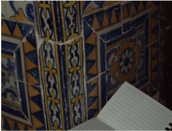
Figura 125 - Encontram-se alguns sais a sair pelas juntas e pelas fissuras no vitrado.
