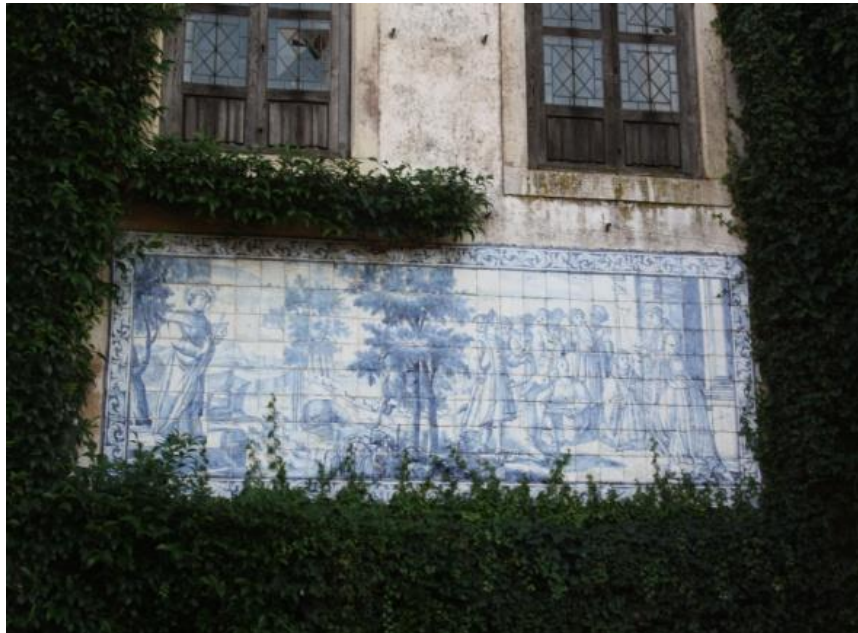
Figura 46 - Painel azulejar na fachada principal.
