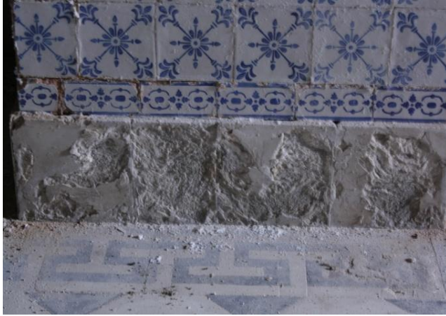
Figura 138 - Rodapé composto por placas cerâmicas, encontram-se com delaminação.
