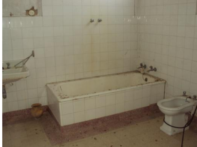
Figura 185 - Azulejo em bom estado de conservação, apenas apresentando manchas de ferrugem junto a tubagens.
