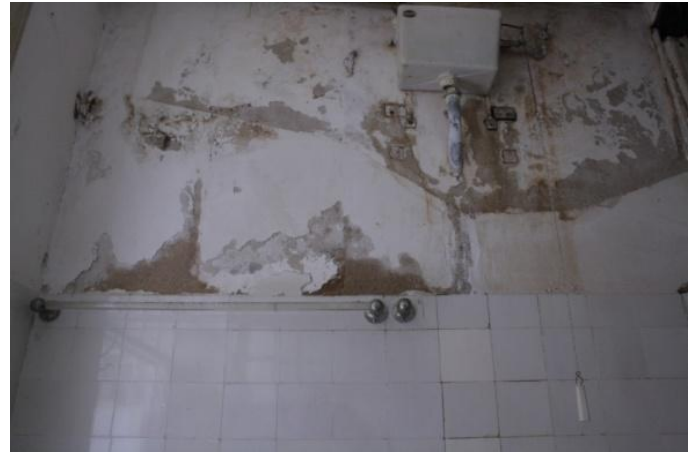
Figura 172 - Nesta divisão parte do tecto já ruiu, sendo um fator de risco eminente.
