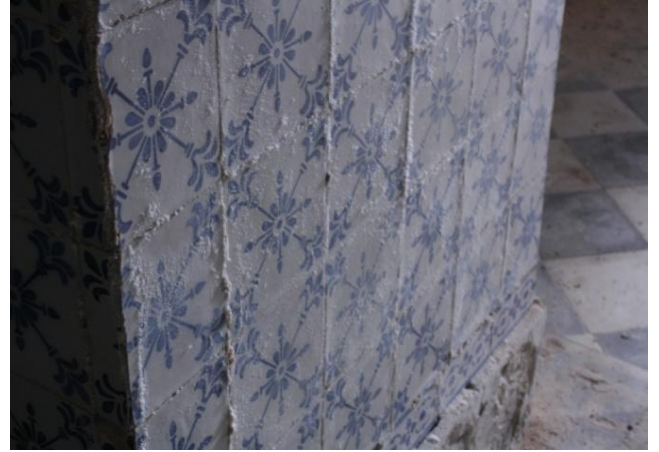
Figura 138 - Rodapé composto por placas cerâmicas, encontram-se com delaminação.
