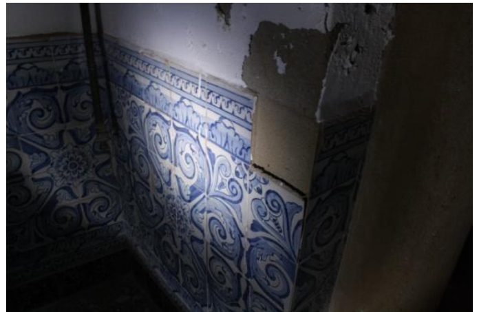
Figura 154 - O silhar de azulejos, sendo estes contemporâneos, estão assentes com argamassas de cimentos.
