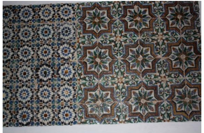
Figura 155 - Devido a sais e humidade, o vidrado de alguns azulejos já começaram a destacar.
