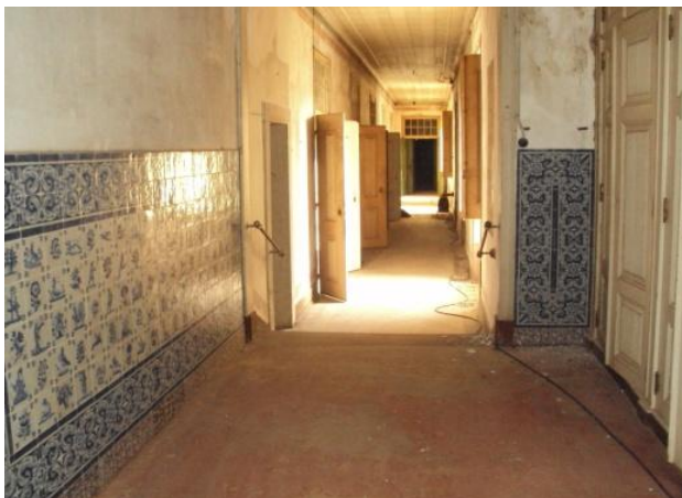
Figura 186 - Silhar de azulejo em bom estado de conservação.
