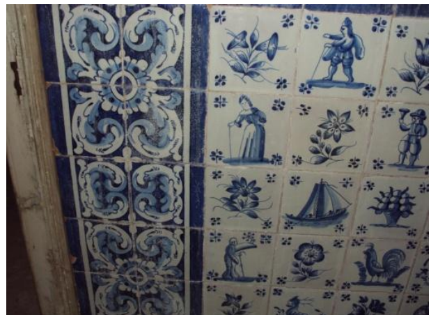
Figura 180 - Do lado norte apresentam saís que se concentram acima do silhar e começam a danificar as juntas.
