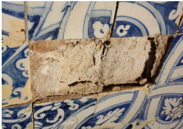
Figura 195 - Mistura de argamassas tradicionais com argamassas de cimento.
