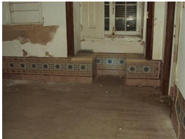
Figura 177 - Azulejos em bom estado de conservação.
