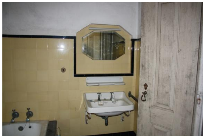
Figura 190 - Azulejo em bom estado de conservação.
