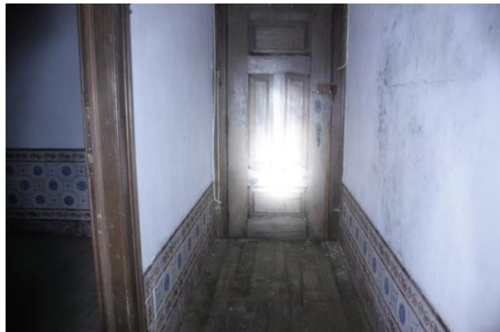
Figura 174 - Azulejos em bom estado de conservação.
