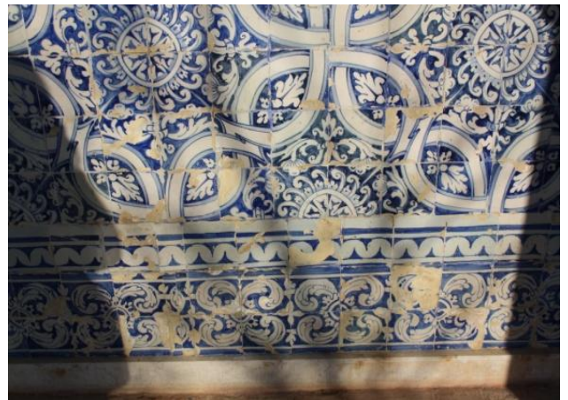
Figura 194 - Grande zona de lacuna azulejar, pela possível falta de coesão de argamassas de assentamento.
