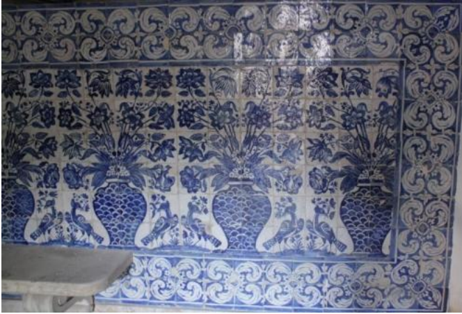
Figura 162 - Silhar de azulejos em bom estado de conservação.
