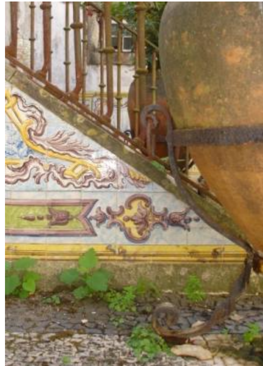
Figura 199 - Muitas fraturas e colonização biológica entre as juntas e na zona de lacunas de vidrado, sobre a chacota.
