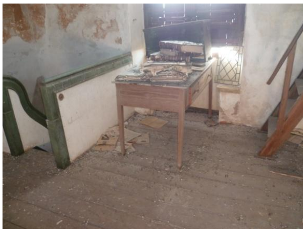
Figura 42 - Um dos pisos da torre medieval.
