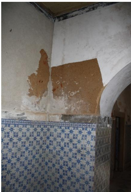
Figura 136 - Zona de humidades, onde já existe o destacamento do estuque e aparecimento de sais.
