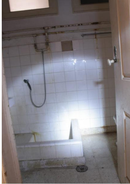
Figura 129 – Vista geral da casa de banho.
