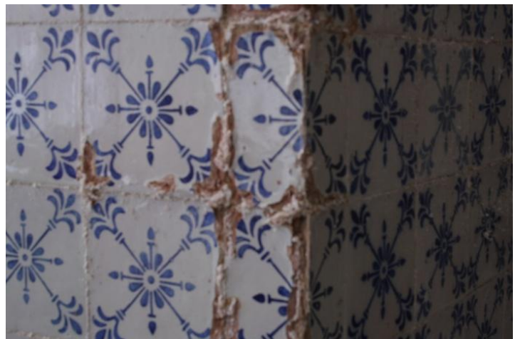
Figura 136 - Zona de humidades, onde já existe o destacamento do estuque e aparecimento de sais.
