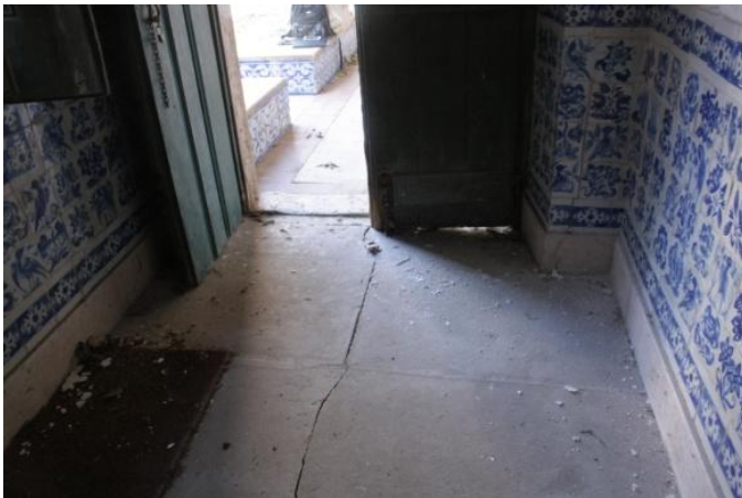
Figura 146 - Existe no local uma falha estrutural, pois uma fenda atravessa o chão desde o exterior e atravessa a sala. Esta patologia poderá criar instabilidade ao edifício que por sua vez danificará o conjunto azulejar.
