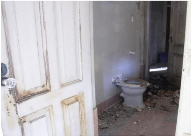
Figura 172 - Nesta divisão parte do tecto já ruiu, sendo um fator de risco eminente.
