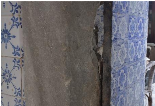
Figura 140 - Uso de argamassa de cimento para colmatação de lacunas.
