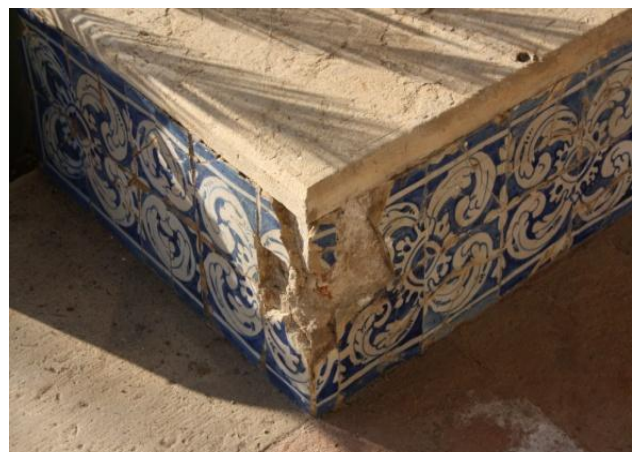
Figura 197 - Fraturas todas do mesmo sentido, indiciam o movimento de águas no material.
