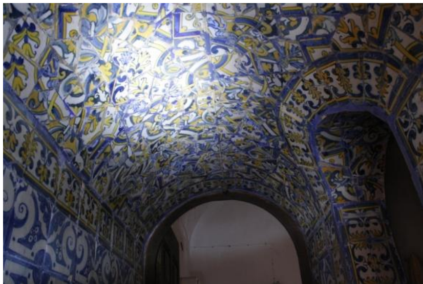
Figura 150 - Aproveitamento de fragmentos para revestimento.
