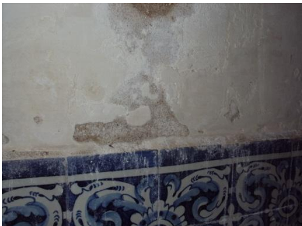
Figura 180 - Do lado norte apresentam saís que se concentram acima do silhar e começam a danificar as juntas.
