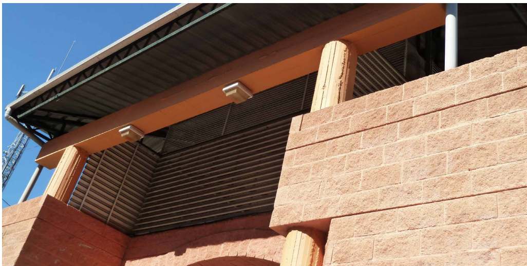
126. Pintado de la fachada principal
