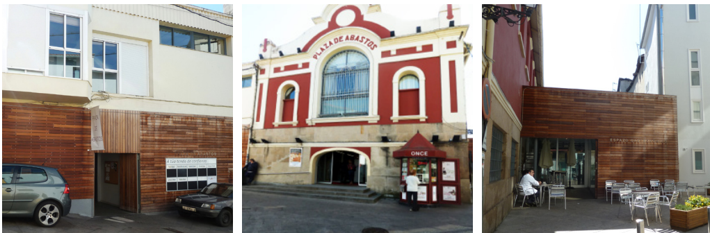
92. Materiales de fachada
