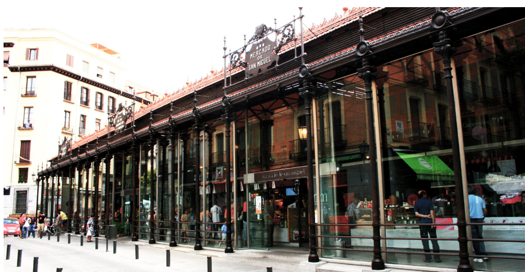
53. Mercado en la actualidad. Fachada Principal
