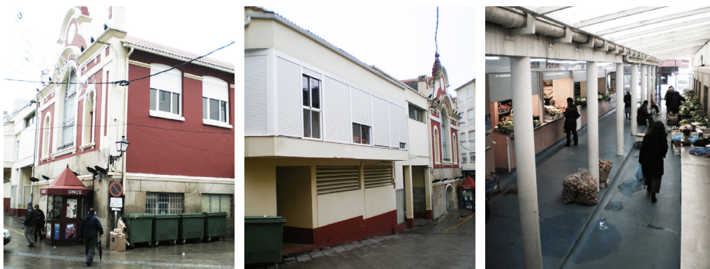
81. Estado del Mercado antes de la renovación
