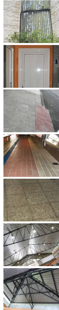
139. Carpintería, pavimentos y cobertura
