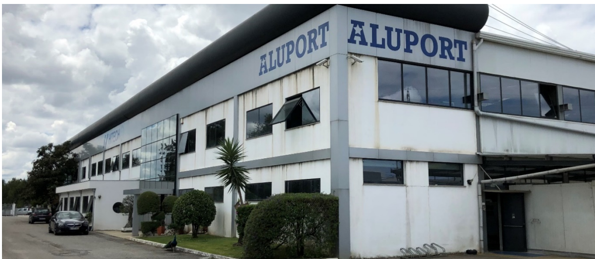
Figura 2 - Instalações da ALUPOINT (Aluport, 2015)
