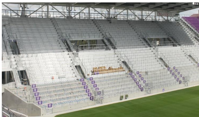
Fig.49: The Wall do Orlando City Stadium Fonte: Orlando City SC
