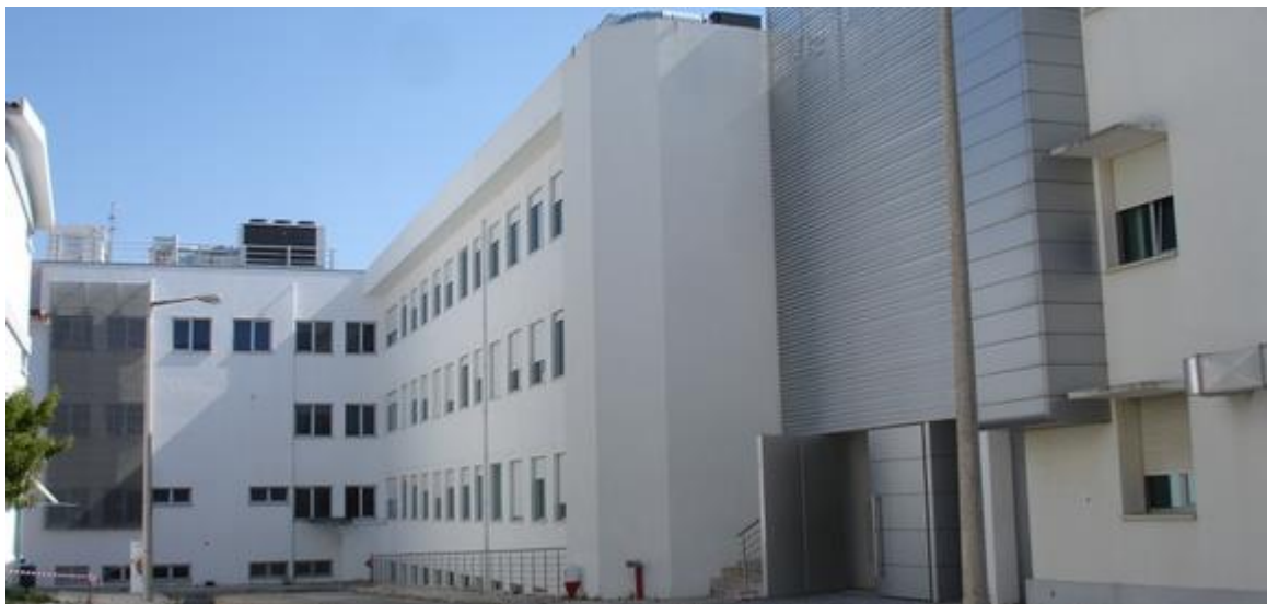
Figura 4: Hospital das Forças Armadas (Pólo do Lumiar)
