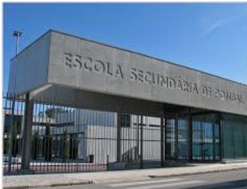
Figura 16 – Vista parcial da escola
