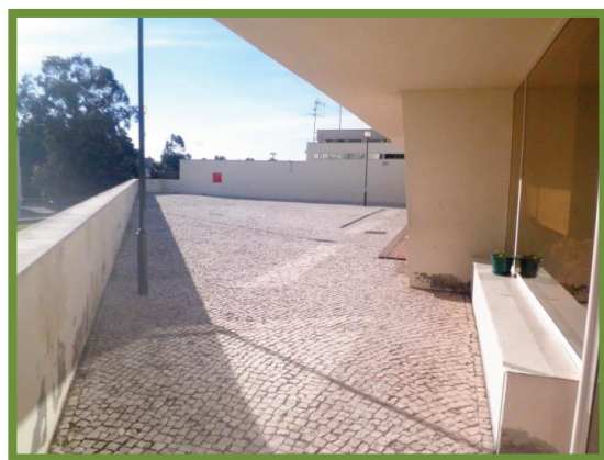
Figura n.º 6 – Terraço (vista lateral)
