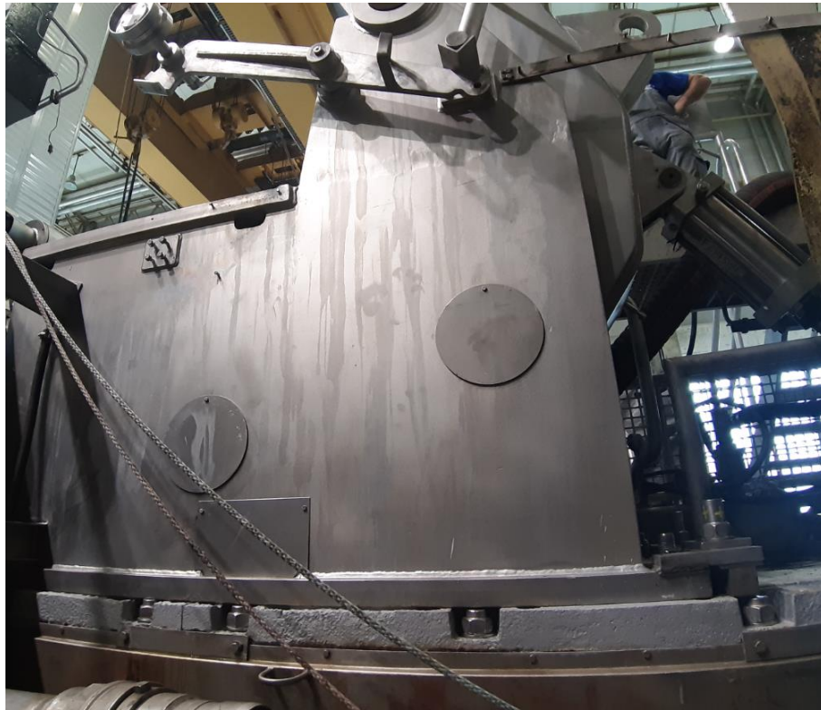
Figura 78 - Montagem da estrutura da Speedsizer.
