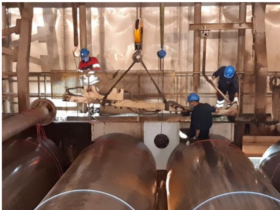
Figura 54 - Montagem dos componentes do grupo secador.
