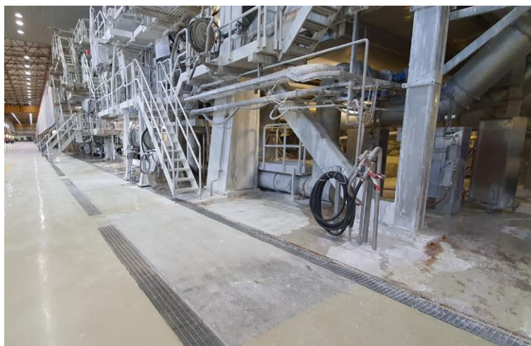
Figura 60 - Zona Húmida antes da pintura do piso.
