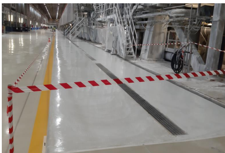
Figura 61 - Zona Húmida depois da pintura do piso.
