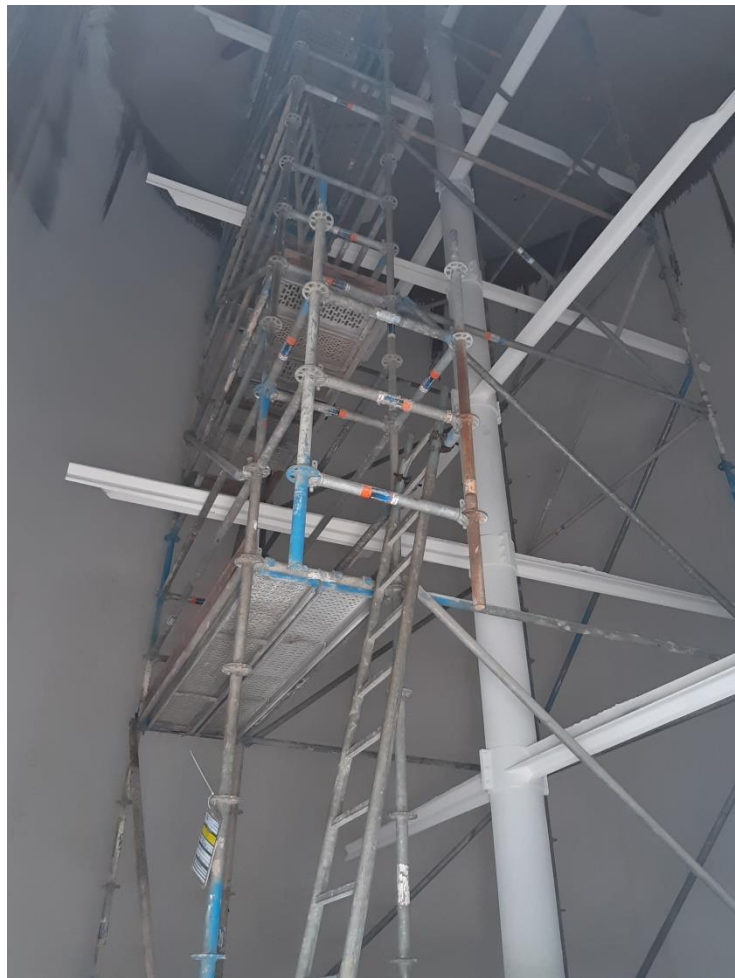
Figura 82 - Montagem de andaime no tanque PCC.
