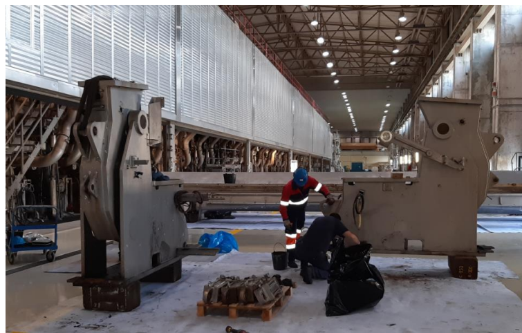
Figura 73 - Remoção da estrutura da Speedsizer.
