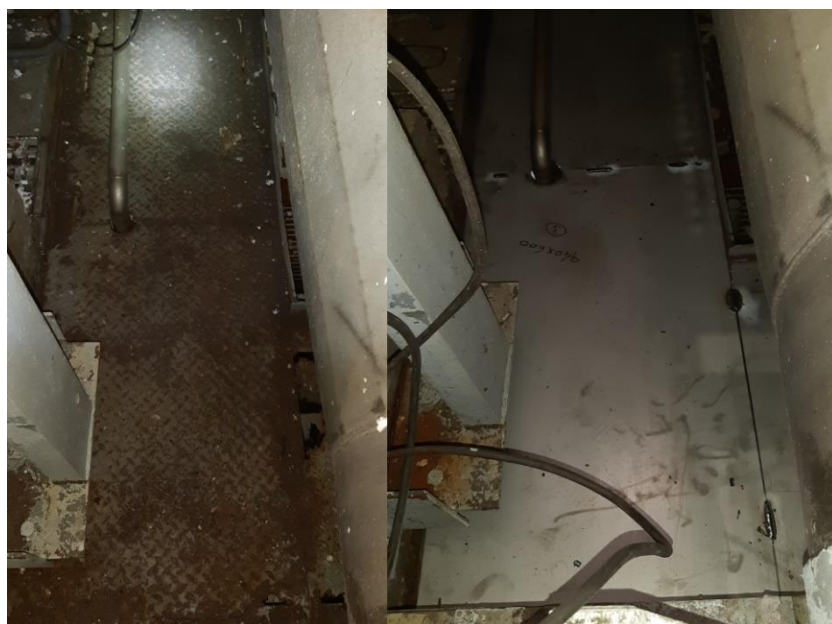
Figura 79 - Substituição de chapas com corrosão.
