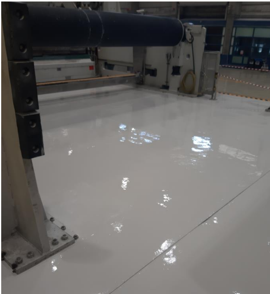
Figura 63 - Zona do Enrolador depois da pintura do piso.
