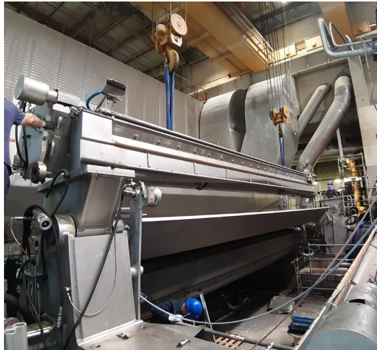
Figura 72 - Remoção dos aplicadores de amido.
