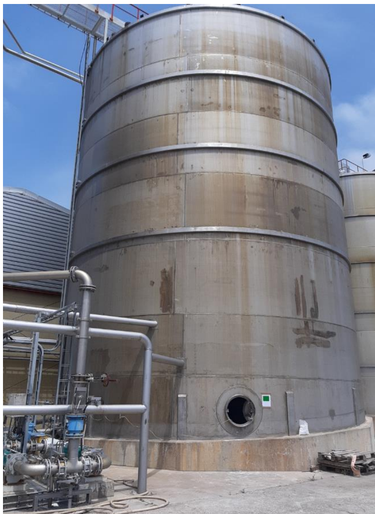
Figura 81 - Tanques de PCC.
