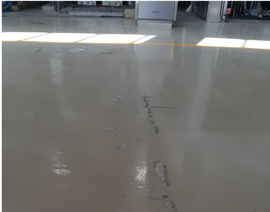
Figura 64 - Zona da Calandra antes da pintura do piso.
