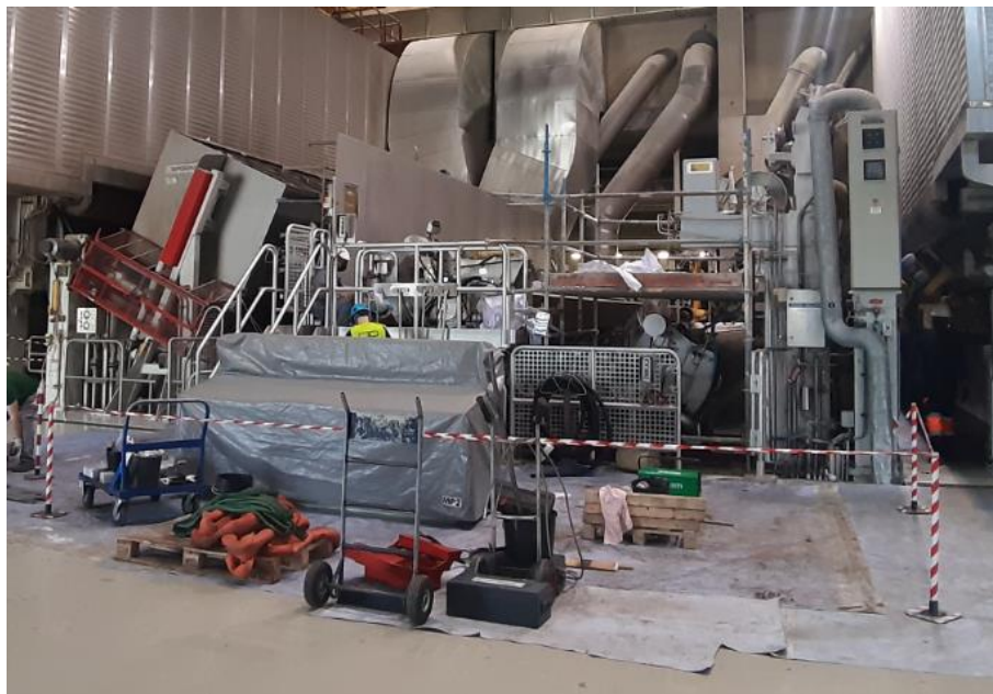
Figura 71 - Desmontagem da Speedsizer.
