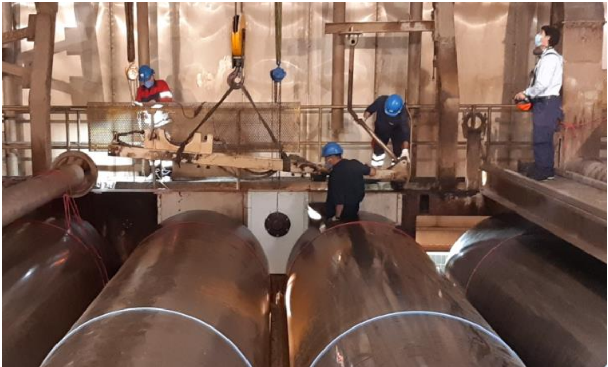
Figura 48 - Remoção dos componentes inerentes à caixa redutora.
