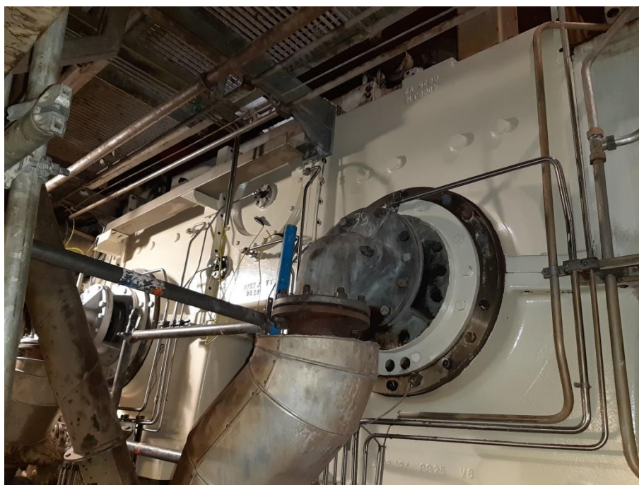
Figura 55 - 7º Grupo totalmente montado.
