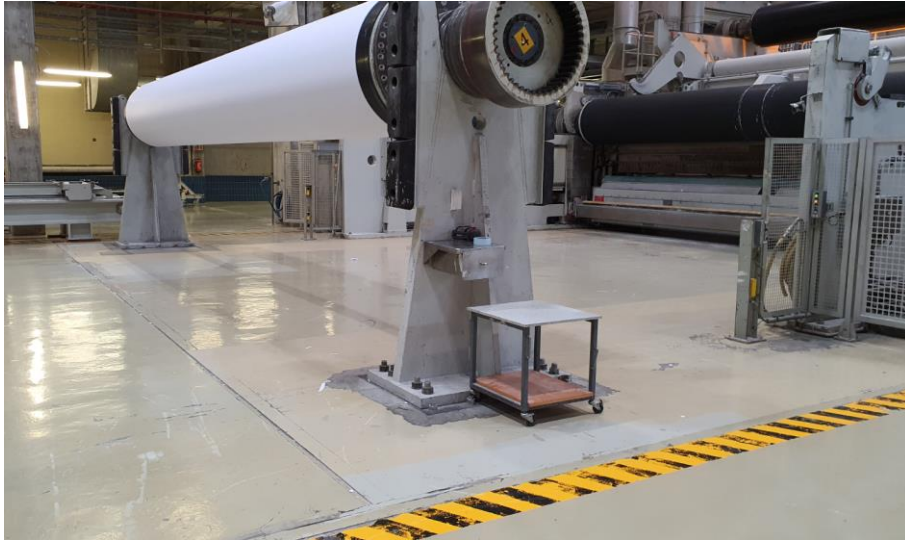
Figura 62 - Zona do Enrolador antes da pintura do piso.
