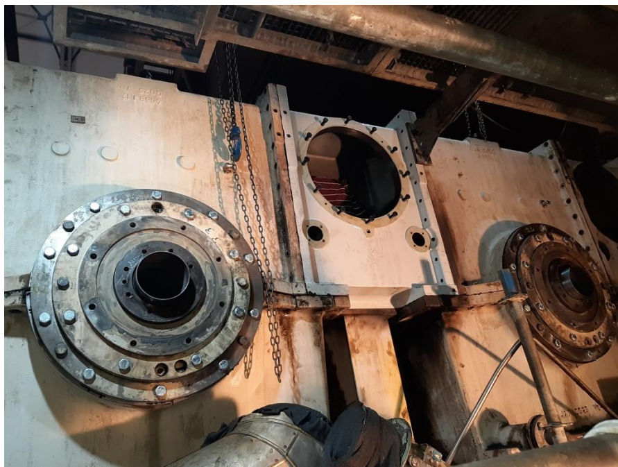
Figura 53 - Montagem da caixa redutora.
