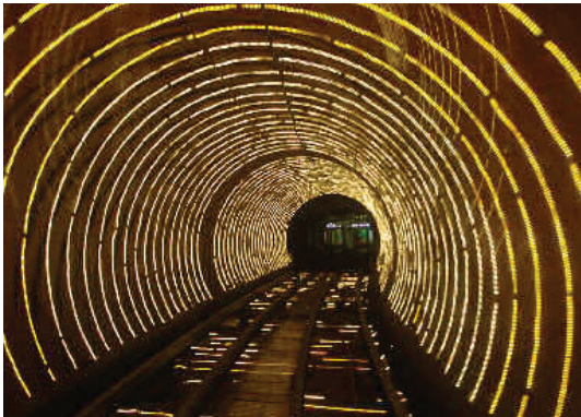
Figura 25 Túnel "Bund Sightseeing"
