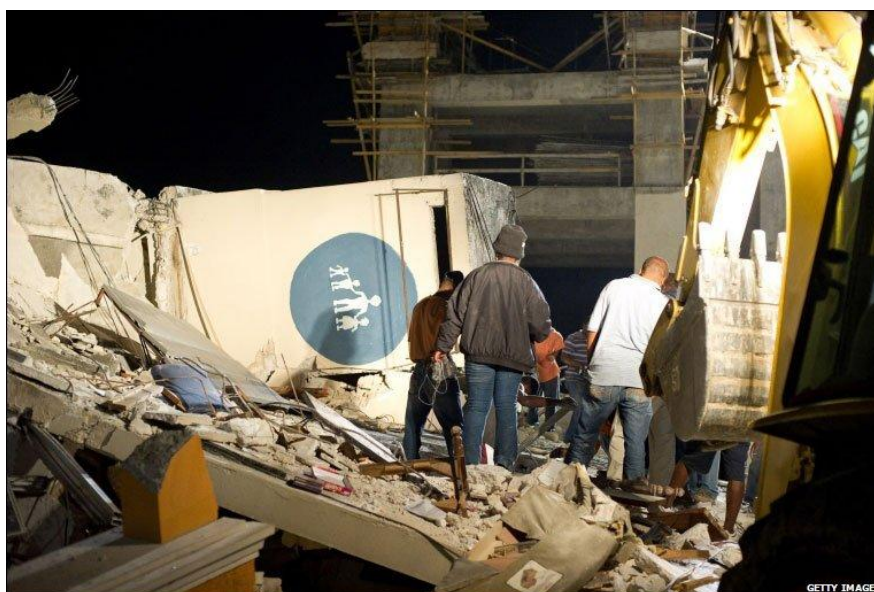
Figura 1.4 – Ruínas de um hospital pediátrico que colapsou no Haiti (8)
