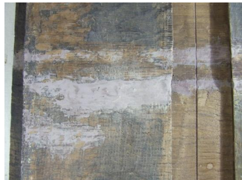
225 – Pormenor junção 1ª e 2ª tábuas, zona superior, após nivelamento do preenchimento
