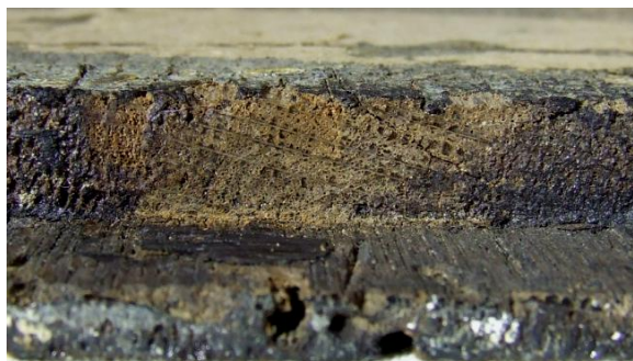
7- Espessura inferior da 3ª tábuas constituinte do painel
