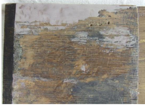
222 – Pormenor canto superior esquerdo após nivelamento do preenchimento
