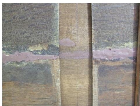
221 – Pormenor junção 3ª e 4ª tábua, zonas inferior e média, após preenchimento
