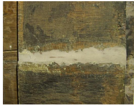
223 – Pormenor junção 2ª e 3ª tábuas, zona inferior, após nivelamento do preenchimento
