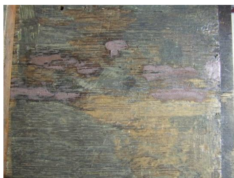
219 - Pormenor 1ª tábua , zona inferior, após preenchimento
