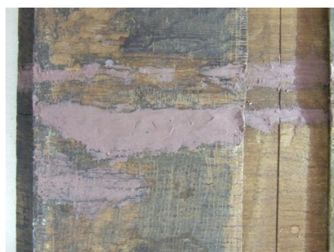
220 – Pormenor junção 1ª e 2ª tábua , zona superior, após preenchimento
