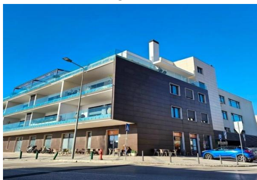
Imagem da Fachada Tiagos Clínica
