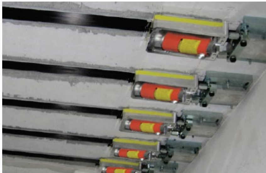
Figura 11- Exemplo de elemento de CFRP laminado, com sistema de pré-esforço (Catálogo S&P C-Laminate)
