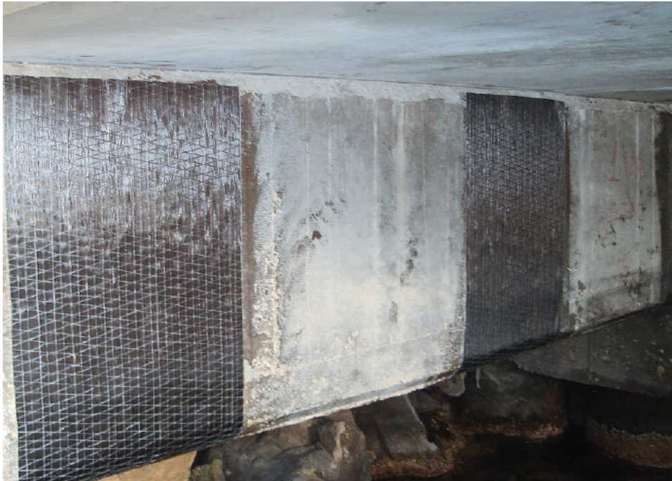
Figura 20- Exemplo de manta em CFRP aplicada em vigas (Ficha Técnica S&P C-Sheet 640)
