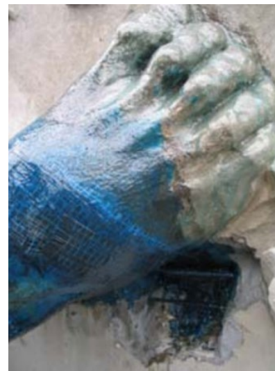
Figura 14- Exemplo de aplicação de manta de CFRP no reforço de um monumento (Juvandes, 2011)
