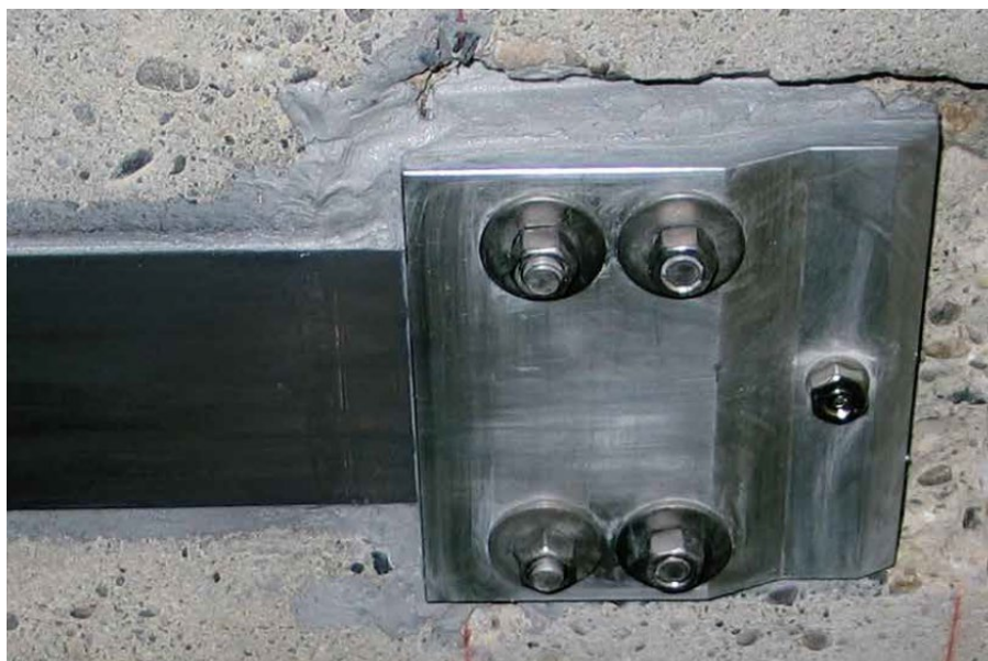
Figura 10- Exemplo de elemento de CFRP laminado com sistema mecânico de ancoragem na extremidade (Catálogo S&P C-Laminate)
