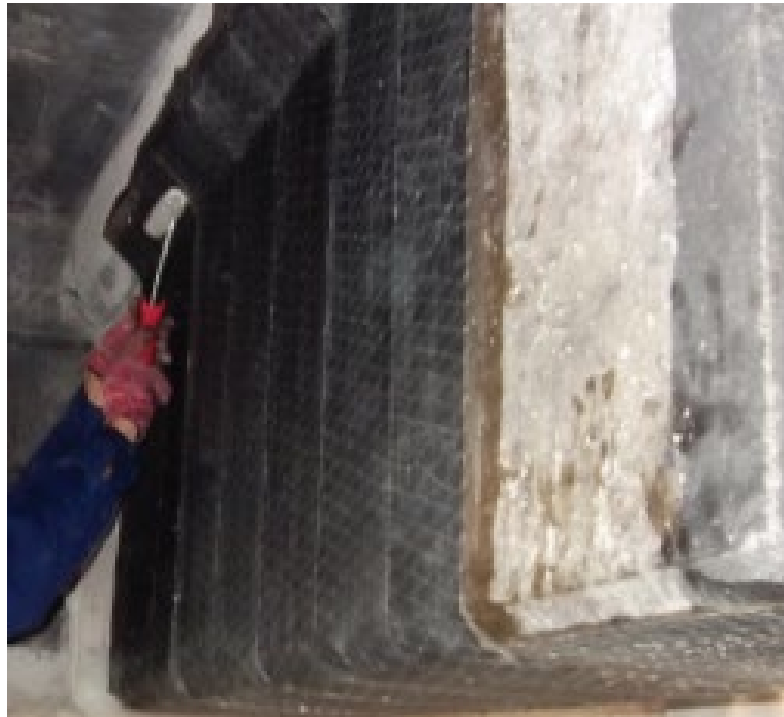
Figura 18- Exemplo de aplicação de manta em CFRP, aplicada em viga (Ficha Técnica/catálogo S&P – C-Sheet 240)
