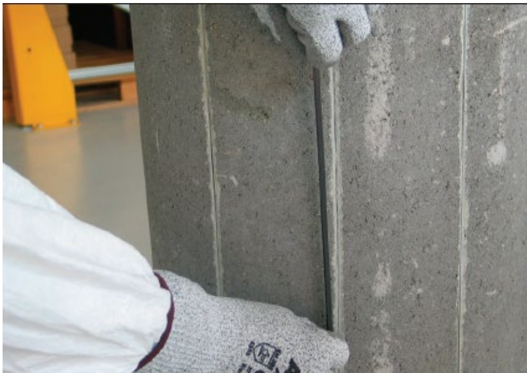
Figura 8- Exemplo de aplicação de laminados em pilar, pela técnica NSM (Catálogo S&P C-Laminate)
