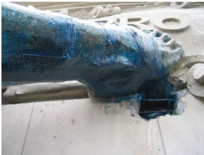
Figura 14- Exemplo de aplicação de manta de CFRP no reforço de um monumento (Juvandes, 2011)
