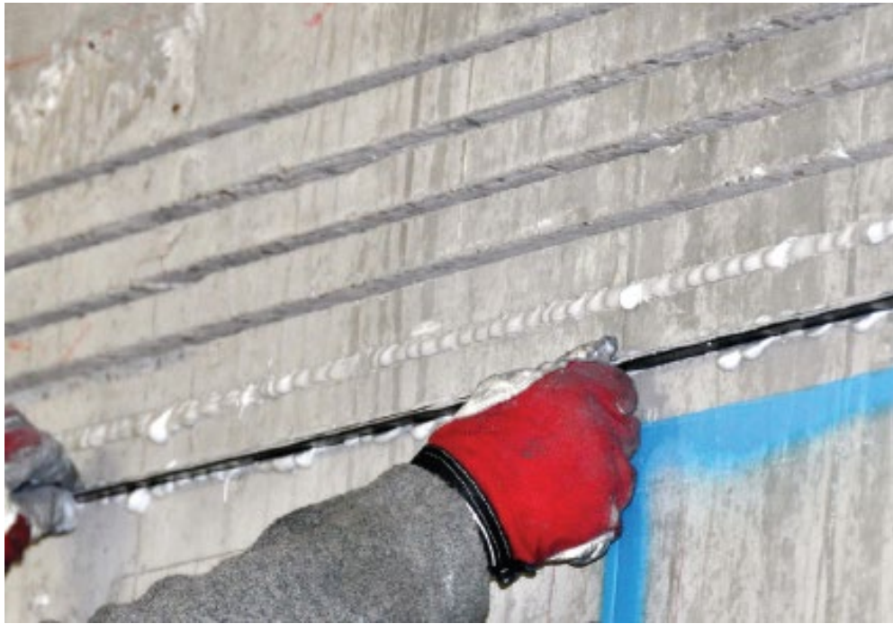
Figura 7- Exemplo de aplicação de laminados em viga, pela técnica NSM (Catálogo S&P C-Laminate)
