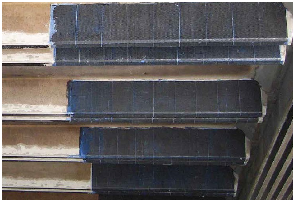
Figura 19- Exemplo de manta em CFRP, aplicada em vigas (Manual de Aplicação S&P – C-Sheet 240)
