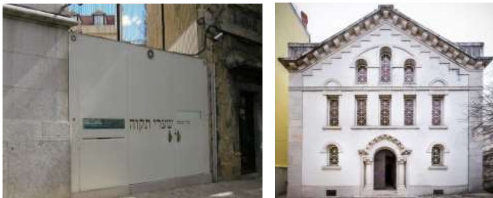
Figura 4 - Portão de entrada para o pátio interior (esquerda) e fachada da sinagoga (direita).
