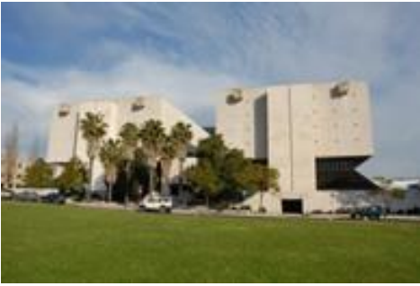
Fig.C1 – Vista exterior do edifício do Arquivo nacional da Torre do Tombo, Alameda da Universidade – Lisboa ( https://antt.dglab.gov.pt/ ).
