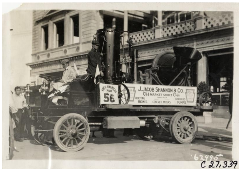
Figura 31 Fotografia de uma das primeiras tentativas para assegurar a mistura contínua durante o transporte, em Atlantic City 1910 [65].
