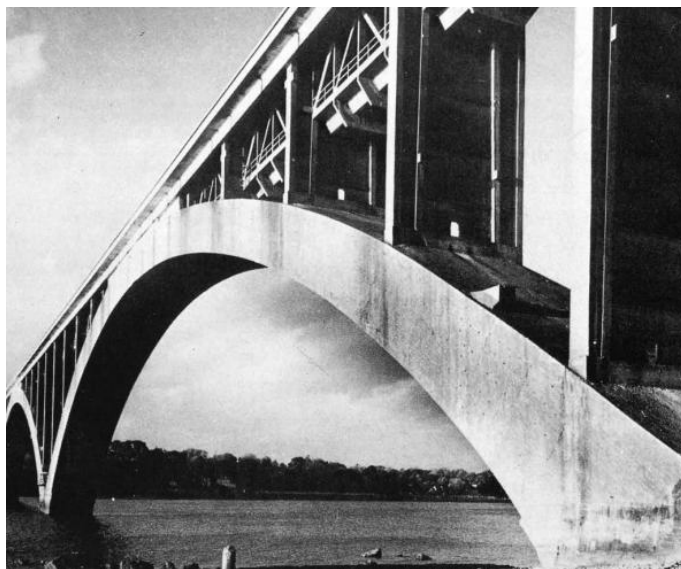
Figura 9 A ponte de Plougastel em 1928. Graças a Eugène Freyssinet, o betão armado tornou-se realidade. Coleção e fotografia da ENPC Paris [18].
