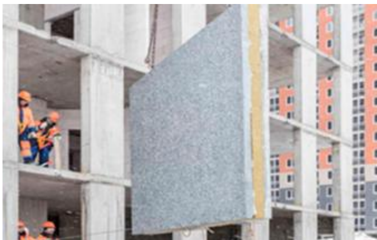
Figura 50 Montagem de parede sanduíche em obra [86].
