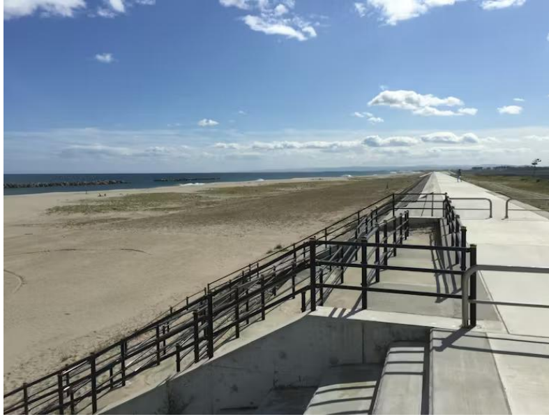
Figura 15 Um dique costeiro reforçado no nordeste do Japão, construído na sequência do tsunami de 2011. Ravindra Jayaratne [32].
