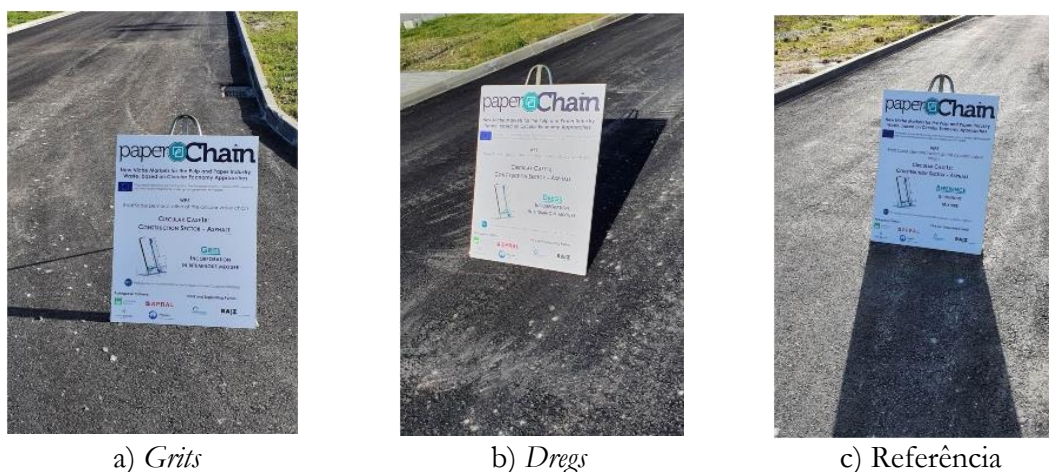
Figura 4.5. Pavimentação asfáltica de camada de desgaste com integração dos resíduos dregs e grits (adaptado de RAIZ, 2020)
