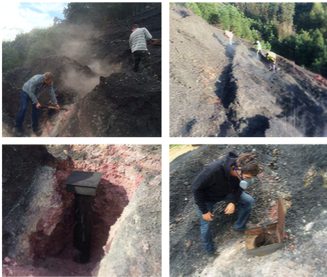
Figura 17 – Fotografias relativas ao processo da instalação do cabo de fibra óptica para medição distribuída da temperatura (cima) e de um dos locais onde foi instalada a estrutura para acolher os sensores de fibra óptica para medição pontual da emissão de gases e da temperatura (baixo) (Ribeiro et al. 2017).
