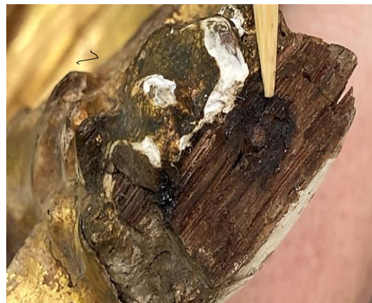
Figura 65- Mancha na madeira em resultado de produtos de corrosão dos pregos. (A.P.)
