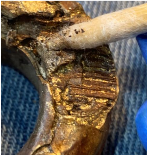
Figura 83- Limpeza por via mecânica e húmida das áreas de repinte com resíduos de purpurinas. (A.P.)
