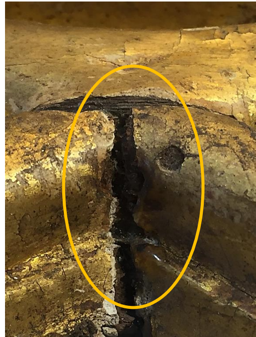
Figura 163 - Reforço da união de uma fratura com pregos de aço macio lizado no brasão de D. Manuel I. (A.P.)
