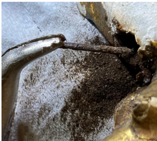
Figura 67- Extração do prego corroído da estrutura em madeira. (A.P.)
