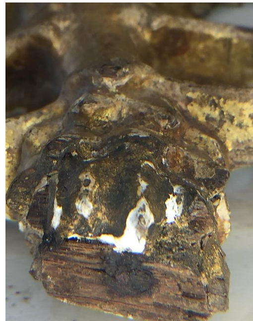
Figura 175- Escurecimento da madeira devido à corrosão dos acessórios metálicos - pregos. (A.P.)
