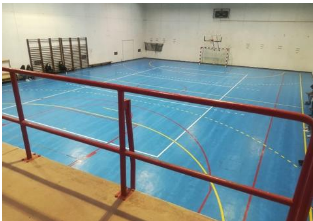
Figura 5 – Pavilhão da escola EB 2.3/S José Gomes Ferreira
