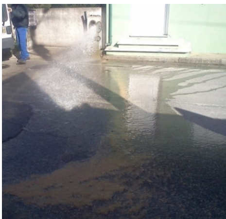
Figura 4.26 – Abertura de uma boca de incêndio, para libertação de água com fragmentos de calcário
