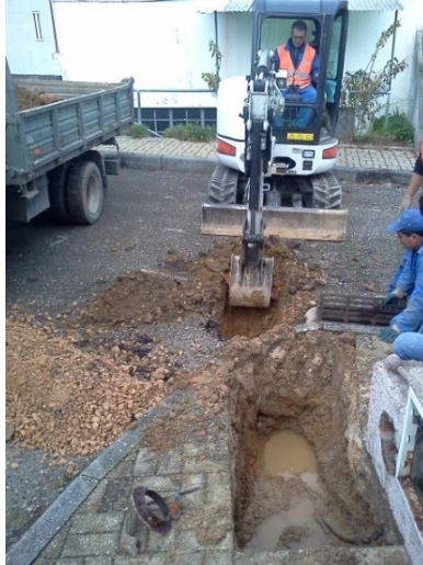
Figura 4.29 – Reparação de rotura
