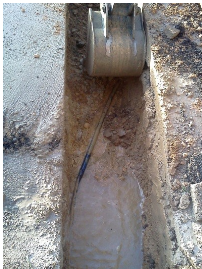
Figura 4.23 – Intervenção num ramal com perdas de água
