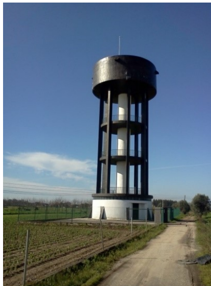
Figura 4.10 – Reservatório do Bolho
