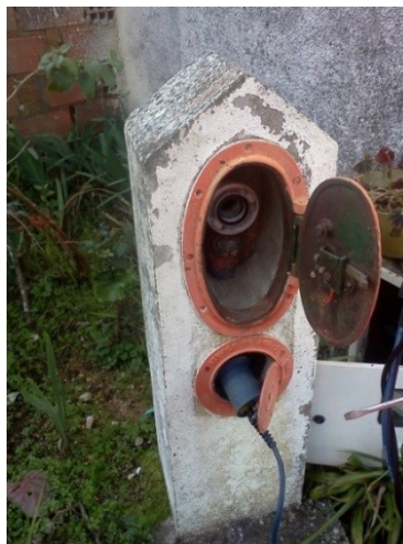
Figura 4.18 – Utilização da vareta de escuta numa boca-de-incêndio
