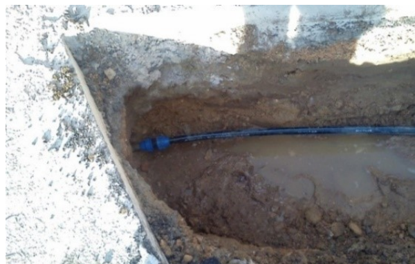
Figura 4.31 – Reparação de um ramal
