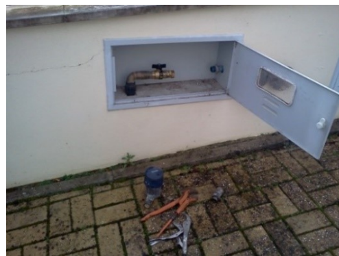
Figura 4.14 – Intervenção num contador doméstico com suspeitas de irregularidades nas leituras.
