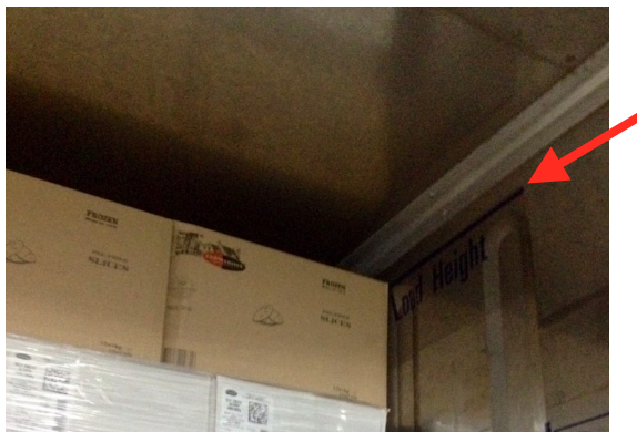
Figura 12 - Verificação do limite de carga máxima.
