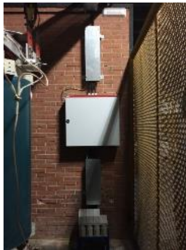
Figura 5.2 – Condensadores 100 kVAr num transformador;
