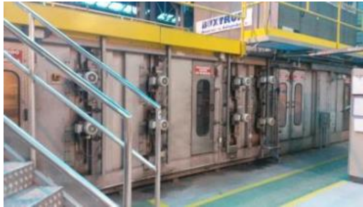
Figura 5.4 – Túnel de lavagem Buxtrup;
