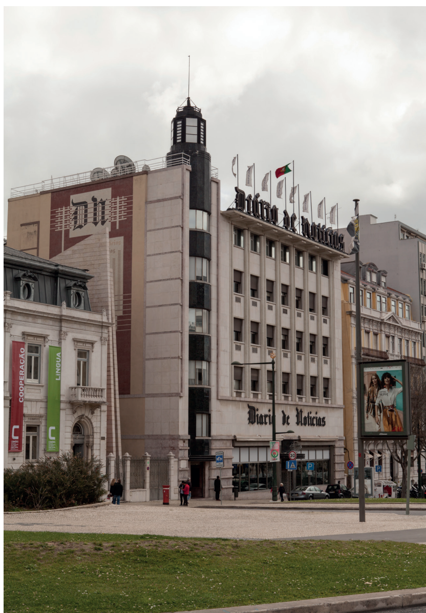
Fig. 2 _ Edifício Diário de Notícias
