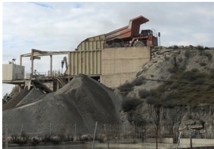
Figura 15 – Dumper a descarregar material para o Primário da Central de Britagem, da Pedreira de Castro Verde.
