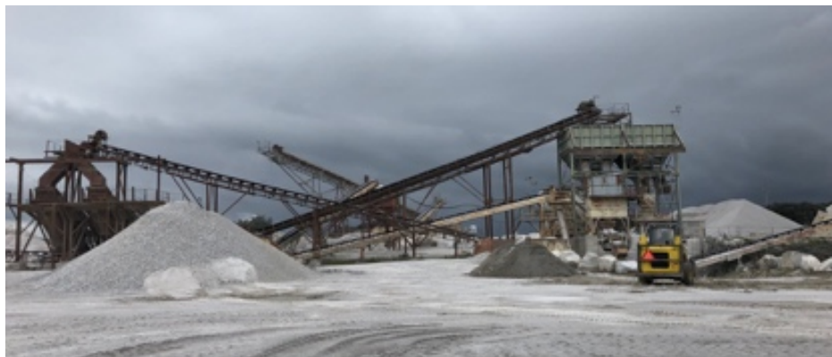
Figura 16 – Vista geral da Central de Britagem da Pedreira de Évora.
