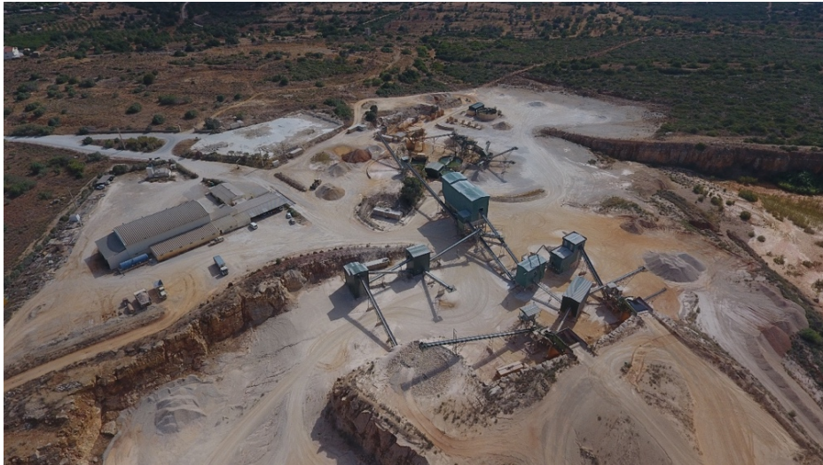
Figura 7 - Vista geral da pedreira de Albufeira.
