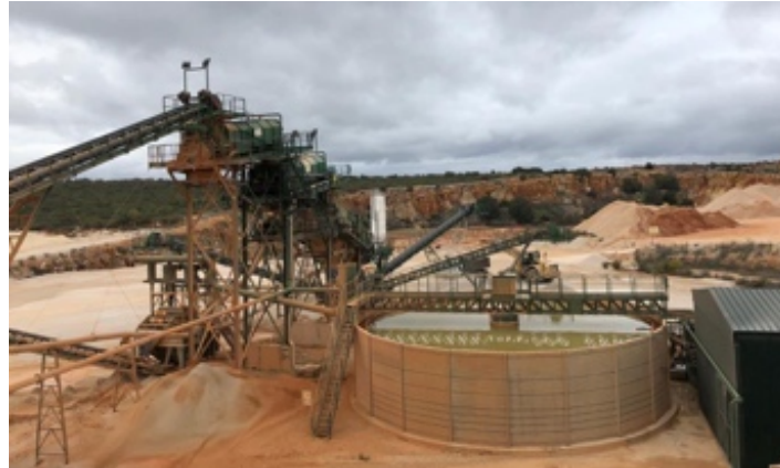
Figura 17 – Pormenor da Central de Areias da Pedreira de Albufeira.
