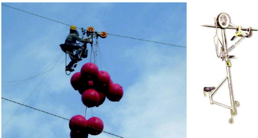
Figura 44 - Uso de bicicleta para fixação de bolas de sinalização [Manuel Bolotinha, 2020].
