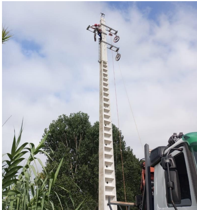
Figura 42 - Fixação de cadeias de amarração.
