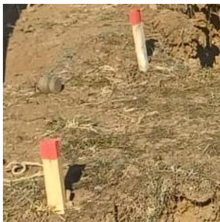
Figura 38 - Estacas de demarcação.
