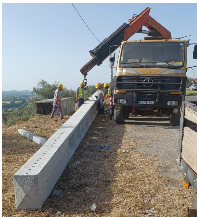
Figura 41 - Levantamento de apoio com caminhão grua.
