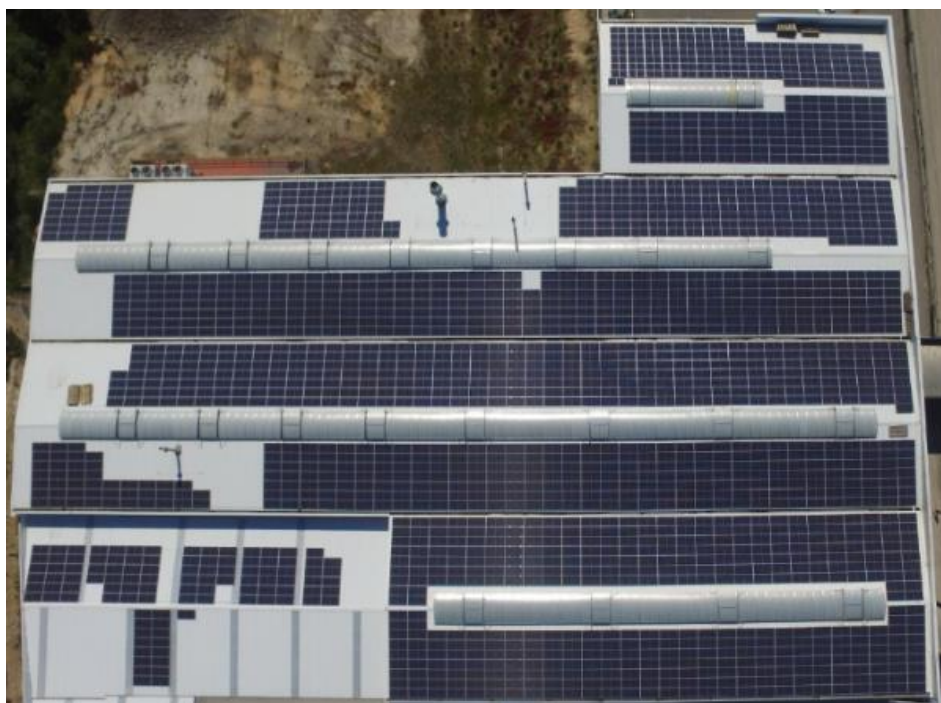
Figura 4.36 - Imagem aérea dos painéis instalados na RODI
