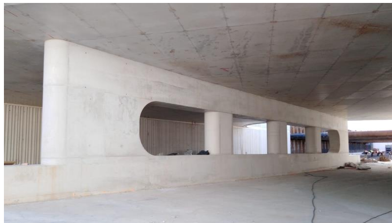
Figura 2.5 - Estrutura de betão da Rijnlandroute Leiden
